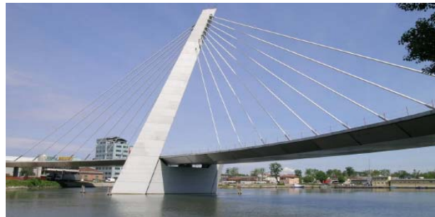
Il ponte strallato in curva di Porto Marghera (Venezia, Italia) - cortese licenza Prof. C. Gentile
