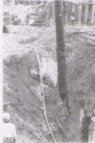
Fig. 2. Palo estratto dal terreno
