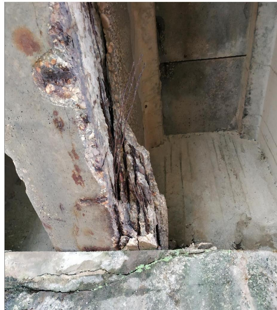
*La prima ispezione viene eseguita per controllare lo stato di qualche armatura corrosa segnalata da persone allarmate!*
