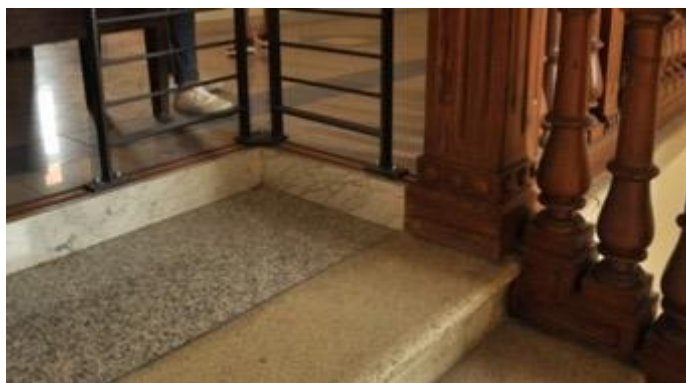
Figura 1.30: Foto scattata in corrispondenza delle scale dove si nota il dislivello rispetto alla quota della vecchia pavimentazione in graniglia di marmo
