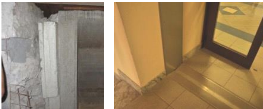
Figura 1.43: Foto che mostrano il giunto del nuovo corpo scale
