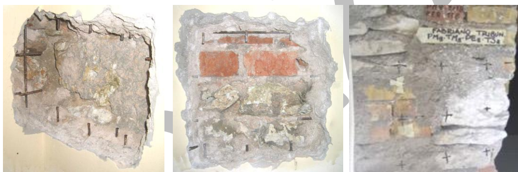
Figura 1.16 Esempi MUR1 rilevati al piano primo, secondo e nel sottotetto.
