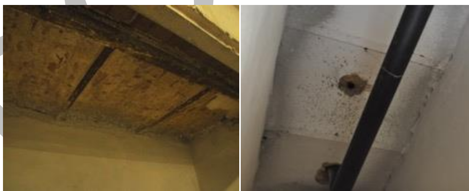
Figura 1.29: Foto dell'intradosso di SOL1
