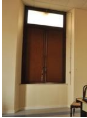
Figura 1.22: Esempio di sottofinestra con sezione muraria ridotta.
