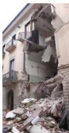
Figura 2.1 Meccanismo di flessione verticale per pareti a più piani.
