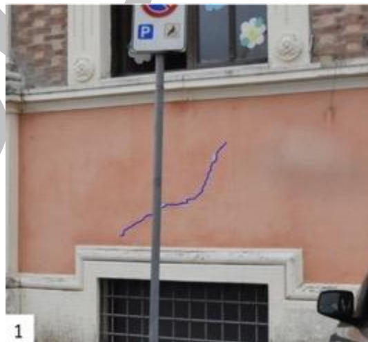
Figura 1.24: Esempio di lesione sulle fasce di piano
