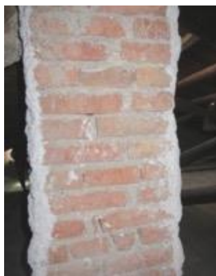
Figura 1.17: Esempio di MUR2 rilevato nel sottotetto
