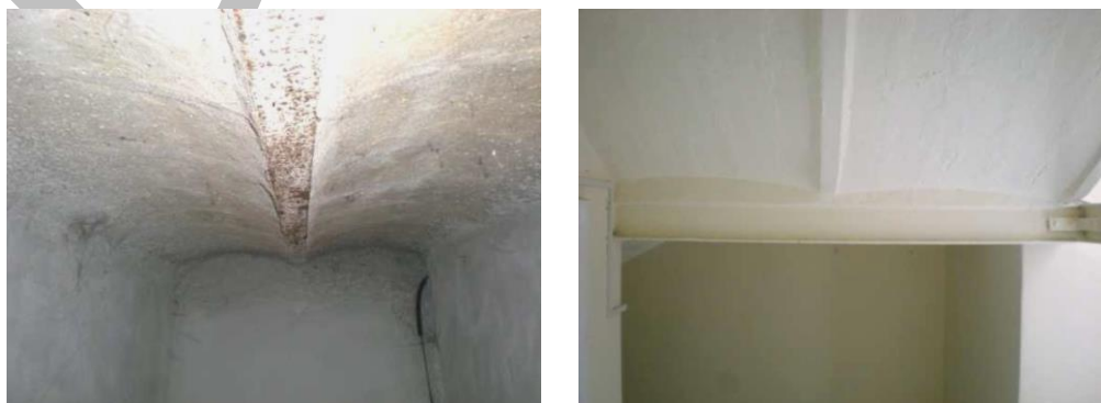
Figura 1.42: Foto dell'intradosso della scala interna
