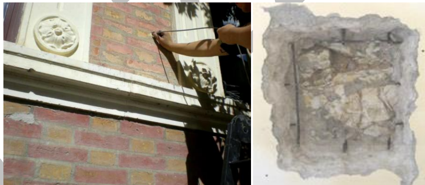
Figura 1.19: Vista esterna dei mattoni facciavista ed interna delle pietre a spacco di MUR3
