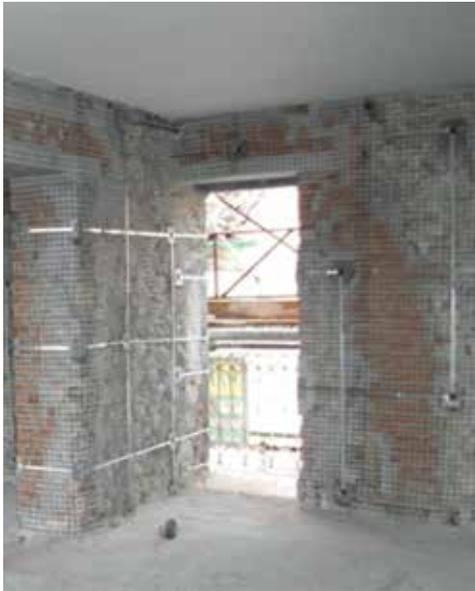
Figura 5.7. Consolidamento delle murature con sistema CAM.
