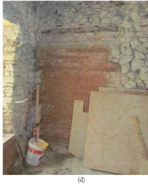
Figura 5.2. Particolare sarcitura di lesioni (a), particolare costruttivo della chiusura di vuoti nelle murature (b) e relative foto degli interventi su strutture esistenti (c), (d).
