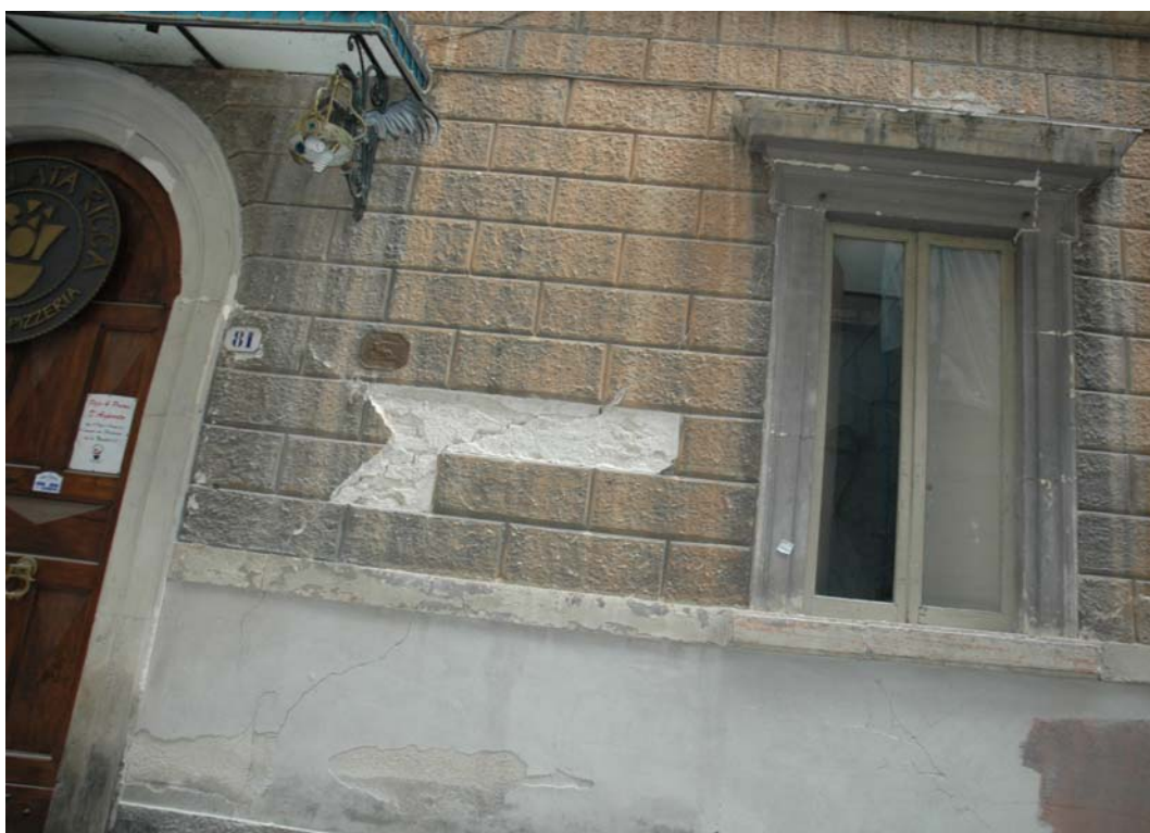
Figura 9. Lesione in un pannello murario di facciata (by A. Balsamo, I. Iovinella, A. Prota)
