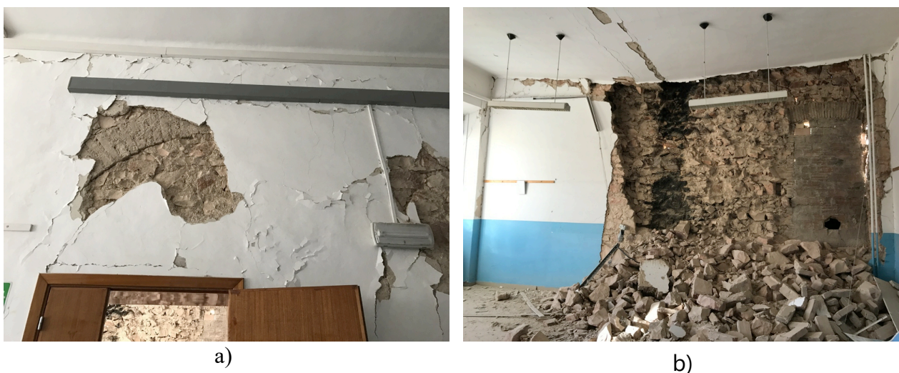
Figura 4. Evidenze sulla presenza di archi tamponati e rimaneggiamenti nella configurazione delle aperture al piano terra (a) e canne fumarie al piano primo (b).
