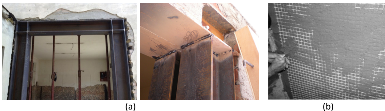
Figura 53. Applicazione di cerchiature delle aperture con profili in acciaio (a) e del sistema FRM come rivestimento delle superfici murarie
