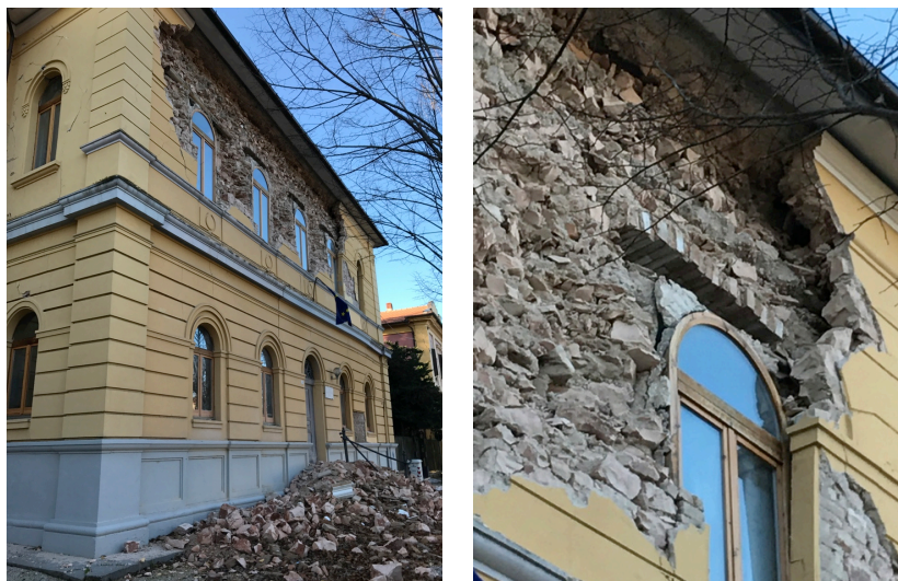
Figura 12. Esempio di meccanismi di danno fuori dal piano
