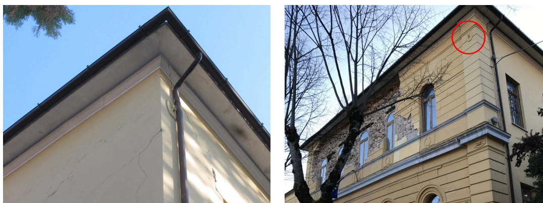
Figura 8. Catene poste nelle pareti corte di estremità
