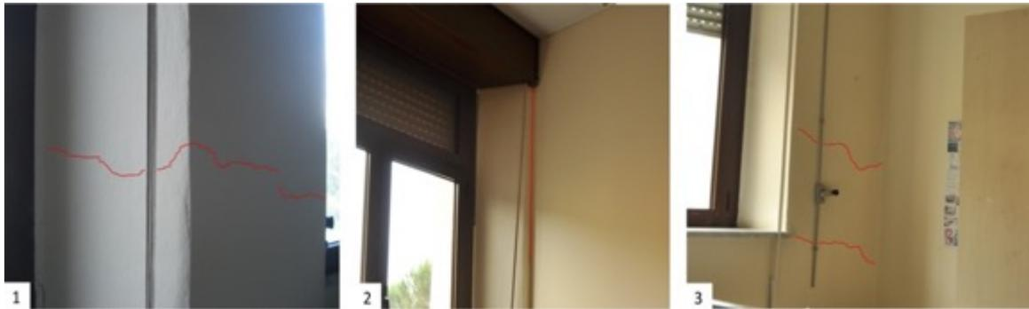
Figura 1.46: Identificazione del quadro fessurativo
