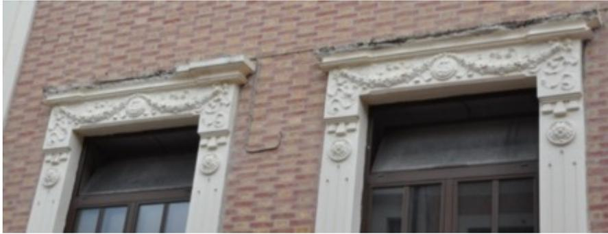
Figura 1.25: Cornicione superiore delle finestre con espulsione del copriferro
