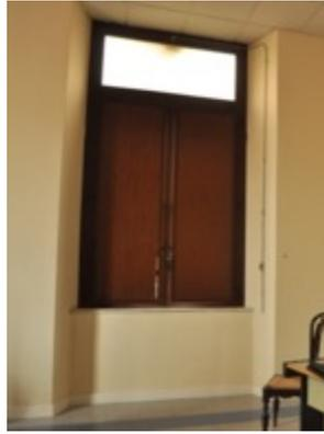
Figura 1.22: Esempio di sottofinestra con sezione muraria ridotta.
