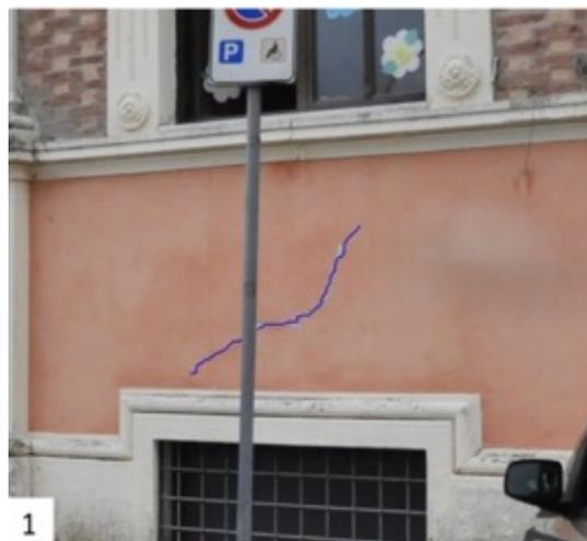
Figura 1.24: Esempio di lesione sulle fasce di piano
