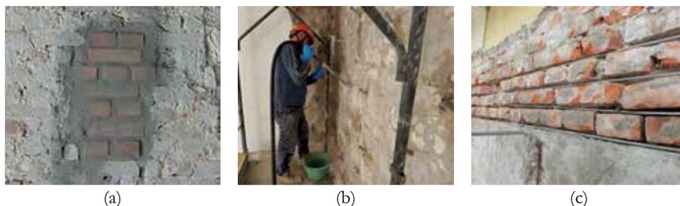
Figura 3.4. a) Scuci-cuci, b) iniezioni, c) ristilatura armata dei giunti.
