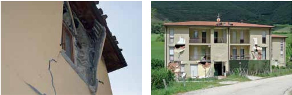
Figura 1.1. Danni provocati dal terremoto del Centro Italia del 2016 a sistemi di isolamento termico installati su edifici esistenti.
