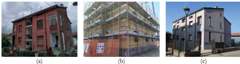
Figura 3.21. Esoscheletri. Riqualificazione integrata di edificio residenziale: edificio allo stato di fatto (a); edificio con esoscheletro strutturale ligneo (b); edificio con involucro strutturale-energetico e architettonico (c) [170, 171].
