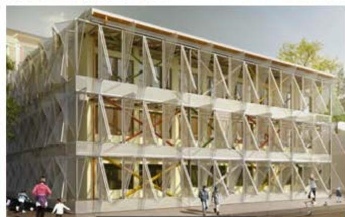
Pannelli di **alluminio microforati**, a **controllo solare**, applicati esternamente
