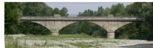
14a - Viadotto Nizza
