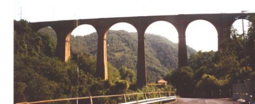
14b - Viadotto Acquasanta
