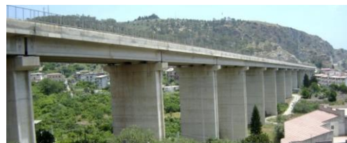
01 – Viadotto Sideroni Osservatorio Sismico
