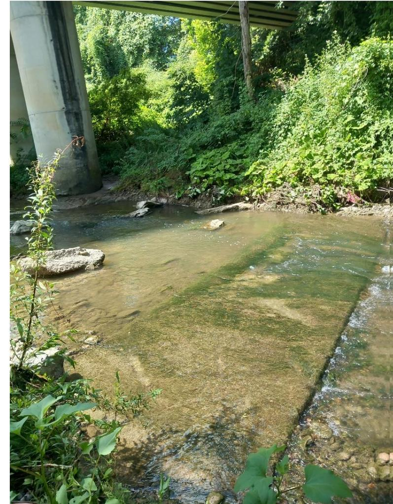
Figura 5 – Particolare della soglia di fondo presente nell'alveo inciso (tra la 1° e la 2° pila in sinistra idraulica)
