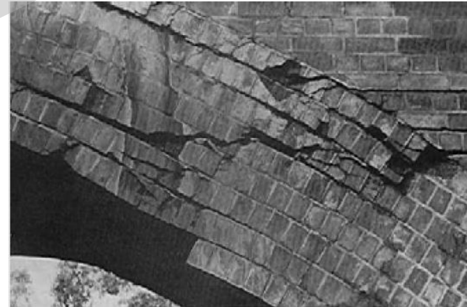
ROTTURA PER COMBINAZIONE FLESSIONE-TAGLIO
