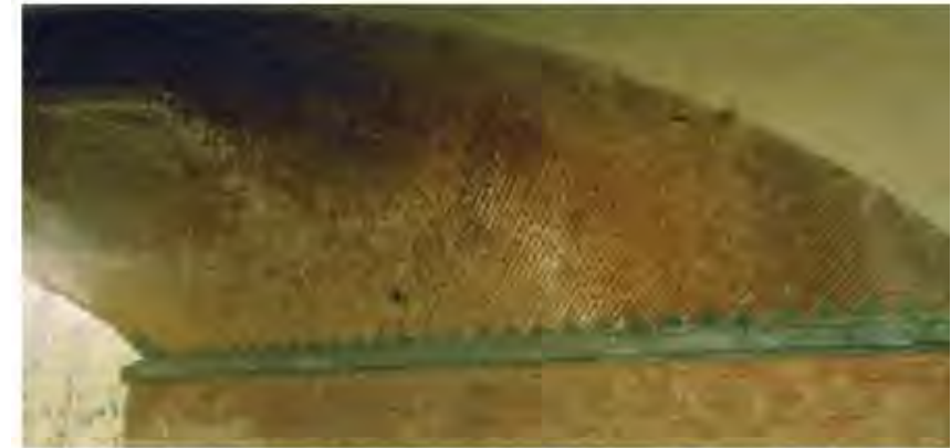
Figura 3 Tessitura elicoidale, ponte Borbone - linea Torino-Genova, progr. 54+797 (Archivio FS - TO)
