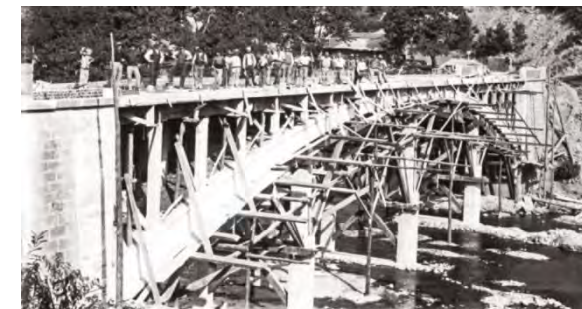
Ponte ad arco in cemento del 1902 sulla Bormida presso Millesimo, edificato da Porcheddu, campata 51m su 5,1m di alzata, rapporto alzata/campata: 1/10,
