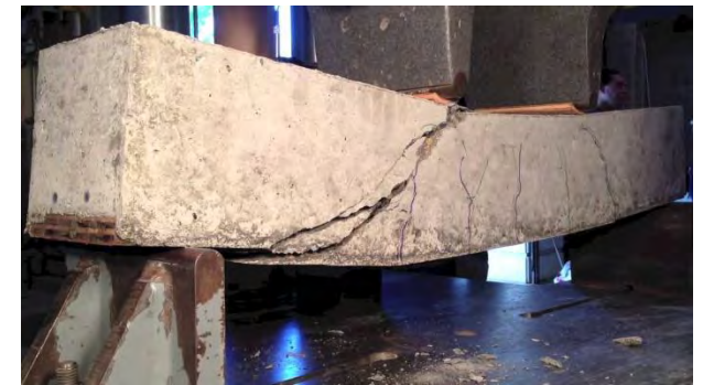
Carenza di armatura a taglio
