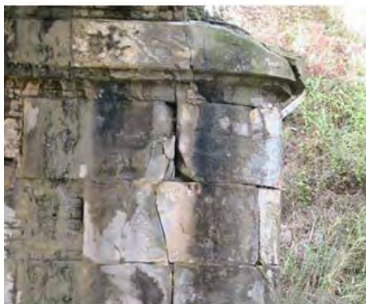
Fessurazione localizzata nell'unione tra la pila e l'elemento di protezione quando le due parti non sono state costruite e collegate omogeneamente.
