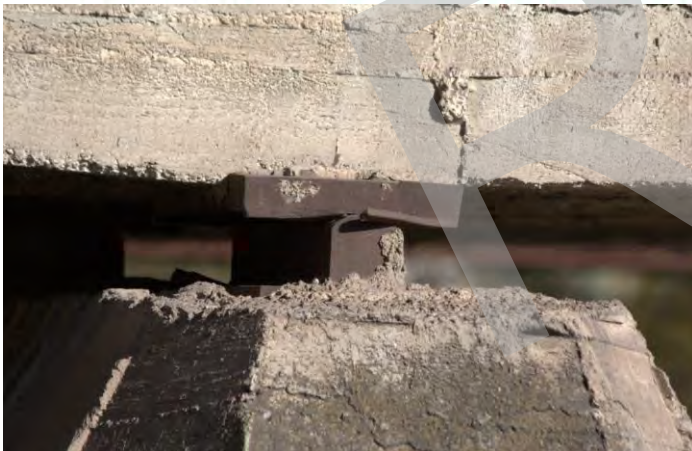
Piastra superiore deformata
