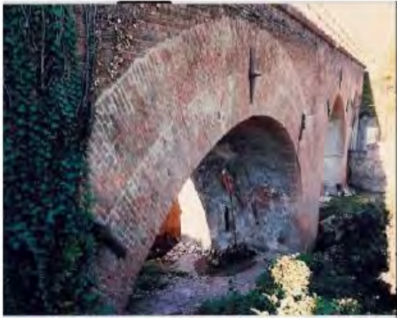
I. Arcata a due strati - linea Savona-Carmagnola, progressiva 44-477 (Archivio FS - TO)
