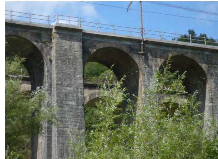
Viadotto a tre ordini di arcate e particolare della pila-spalla (Curioni, 1871).
