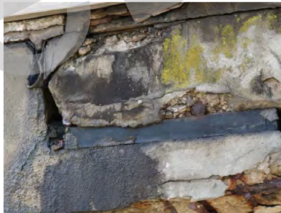
Invecchiamento neoprene (appoggio su sella Gerber)
