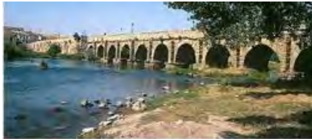
11. Salaparuta. Ponte sul fiume Tressera, costruito a partire dallo scudo
