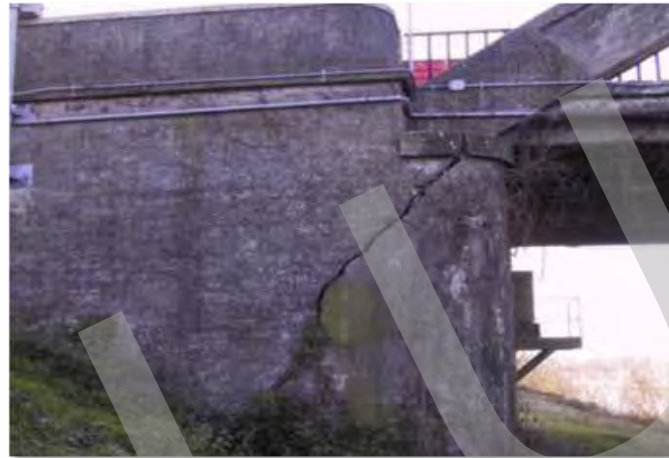
Lesione schiacciamento spalla
