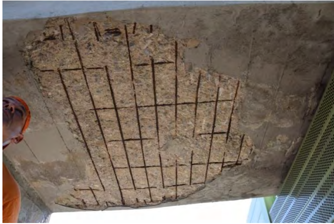
Degrado dell'arco
