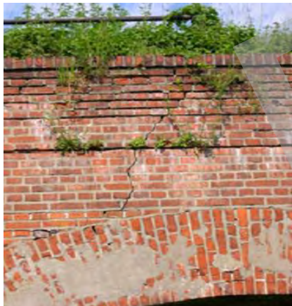
Fessurazione verticale del timpano
