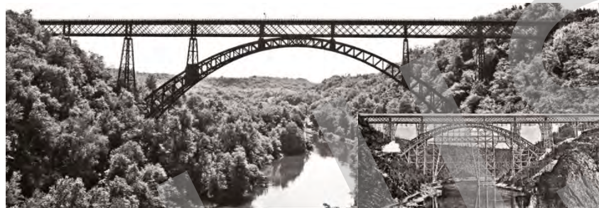
1889 Ponte ad arco in ferro a Paderno d'Adda, delle Officine Savigliano, luce 150 m, altezza 80 m, lunghezza 260 m
