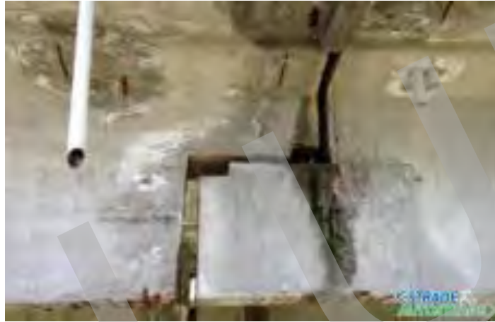
Degrado apparecchi di appoggio
