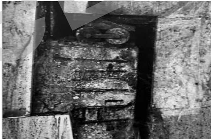
Degrado apparecchi di appoggio
