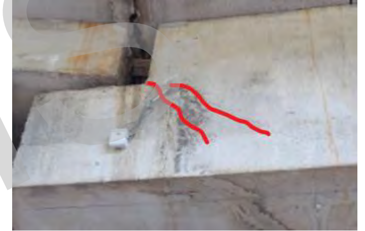
Fessure diagonali in corrispondenza delle selle
