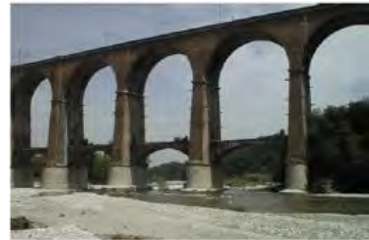
Figura 25. Viadotto Sours - linea Fossano-Ceva, prog. 2-606 (archivio FS-TO)
