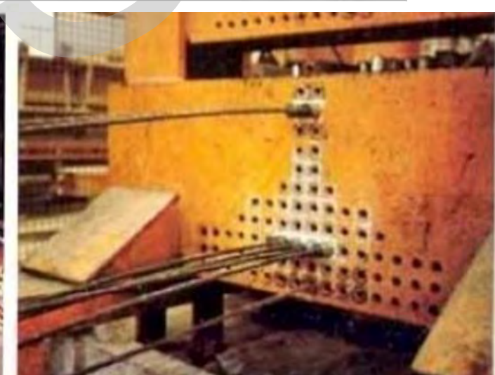
Blocco di ancoraggio dei cavi
