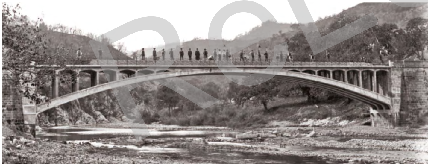
Ponte ad arco in cemento del 1902 sulla Bormida presso Millesimo, edificato da Porcheddu, campata 51m su 5,1m di alzata, rapporto alzata/campata: 1/10,
