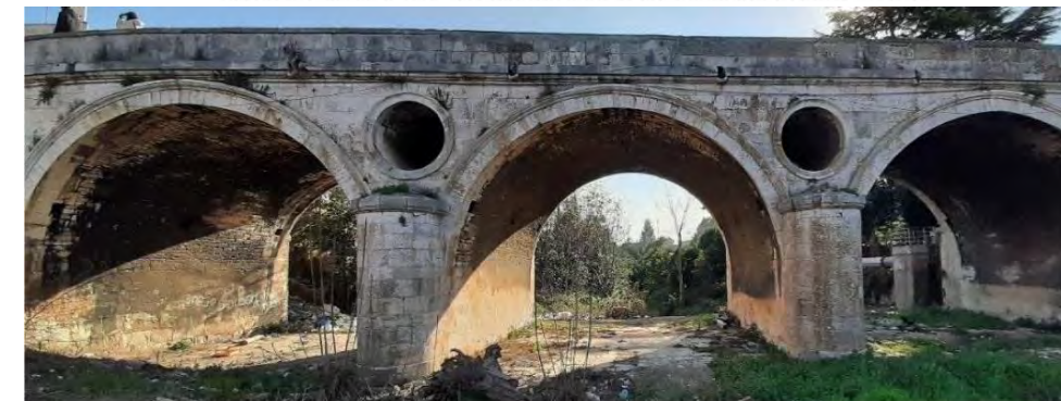
Figura 49. a- Rinfianco alleggerito con archi (Curioni, 1871), b- Rinfianco alleggerito del ponte Stenevasso - linea Torino-Genova, progr. 37+733 (Archivio FS - TO)
