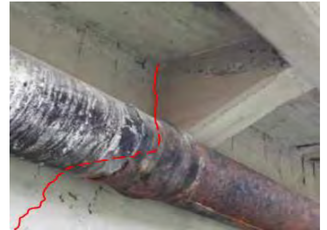
Lesioni distacco travi/traversi
