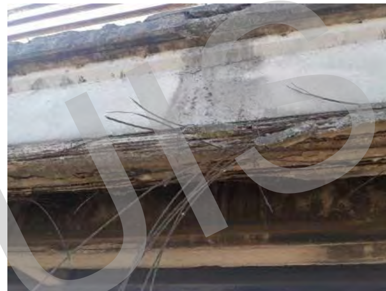
Riduzione armatura da precompressione
