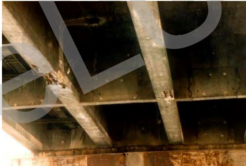
corrosione armature
