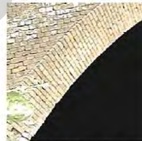
Particolare di arcata, ponte Dora - linea Torino-Milano, progr. 5+915
