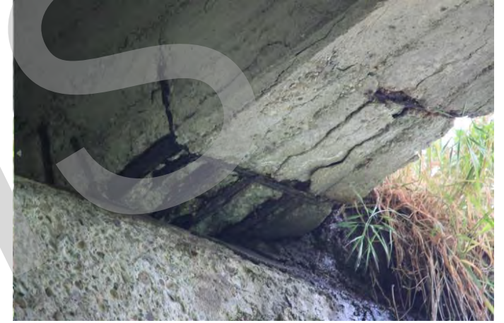
Lesioni distacco travi/traversi
