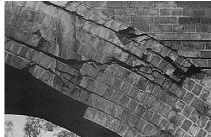
ROTTURA PER COMBINAZIONE FLESSIONE-TAGLIO
