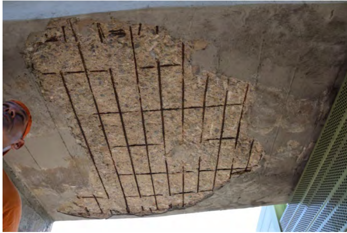
Degrado dell'arco
