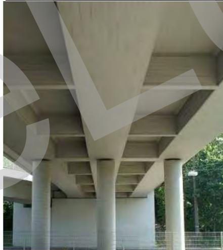
**Pila a telaio**
