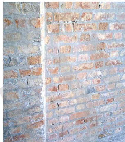
Fessurazione localizzata tra spalla e muro laterale; frequente nei ponti ad arco caratterizzati da muri laterali di una certa altezza e soggetti ad instabilità del terreno di riempimento
