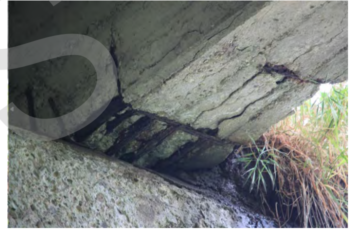
Lesioni distacco travi/traversi
