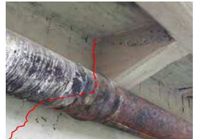
Lesioni distacco travi/traversi
