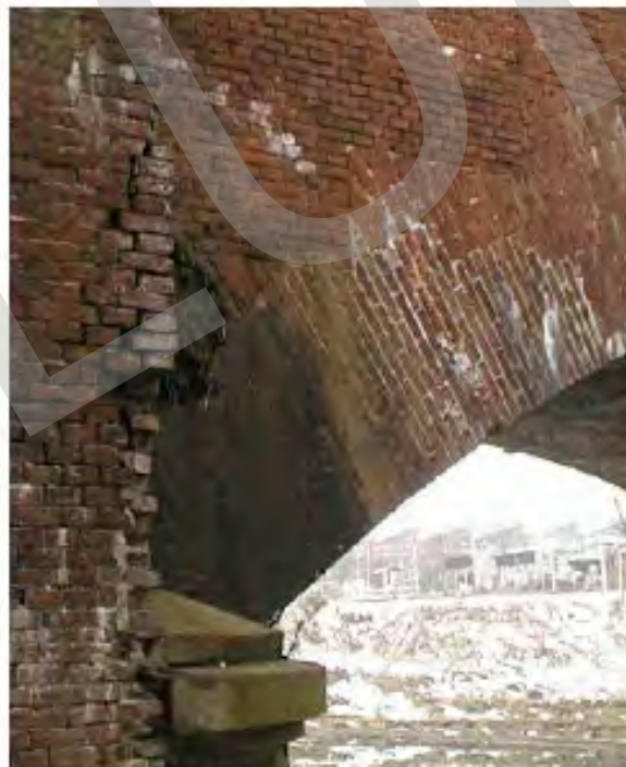
Estradosso dell'arcata scalettata - ponte Sangone - linea Torino-Genova, (Archivio FS - TO).
