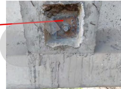
Traverso gettato in opera e collegato alle travi con barre diwydag e piastra. La piastra è nascosta del getto di ricoprimento del calcestruzzo. Si vede solo rimuovendo il calcestruzzo ma si può ipotizzare considerando che le travi sono prefabbricate e il traverso gettato in opera dopo.
