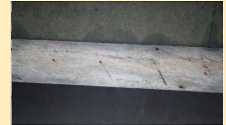
Da 3 a 4: Avanzamento fase di propagazione e forti perdite di sezione trasversale accompagnate da perdita del copriferro
