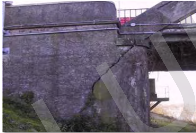
Lesione schiacciamento spalla
