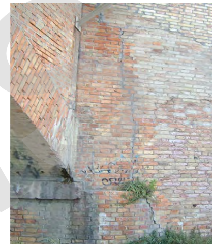
Fessurazione localizzata tra spalla e muro laterale; frequente nei ponti ad arco caratterizzati da muri laterali di una certa altezza e soggetti ad instabilità del terreno di riempimento
