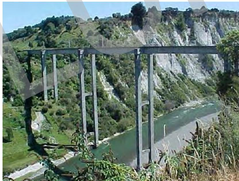
La presenza di ulteriori parametri di vulnerabilità sismica che caratterizzano specificatamente lo schema strutturale del ponte, quali impalcati sghembi o in curva, pile a singola colonna o con altezza molto disuniforme, presenza di appoggi particolarmente soggetti a degrado o comunque situazioni che determinano concentrazioni di sforzo, moti rotazionali o quant'altro costituisce un aggravante alla vulnerabilità del ponte è da tenersi in debito conto.
