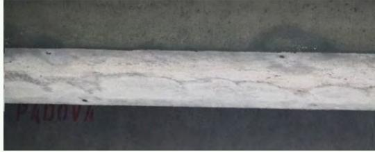
Da 1 a 2: Ossidazione delle armature e prima fase di propagazione con perdita di sezione trasversale armature accompagnati da fessure da splitting lungo lo sviluppo delle armature
