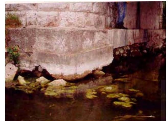
Scavo localizzato alla base della pila
