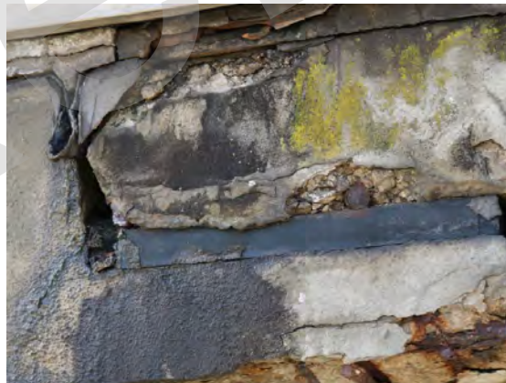
Invecchiamento neoprene (appoggio su sella Gerber)
