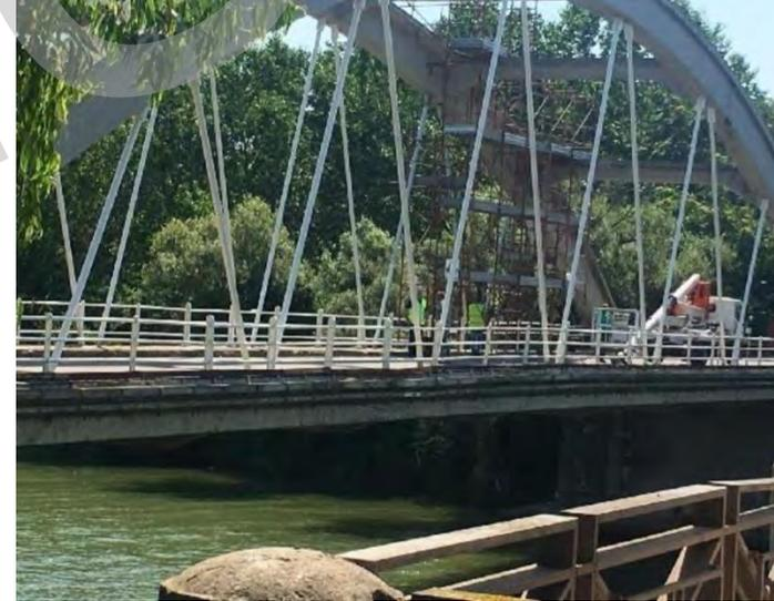
Principalmente **assemblaggio in opera con centina**, l'impalcato è costruito tramite l'utilizzo di pile provvisorie, la centina che permette la costruzione dell'arco viene appoggiata direttamente sull'impalcato. Successivamente alla costruzione dell'arco vengono messi in opera i pendini, quindi rimossa prima la centina, poi le pile intermedie provvisorie.
