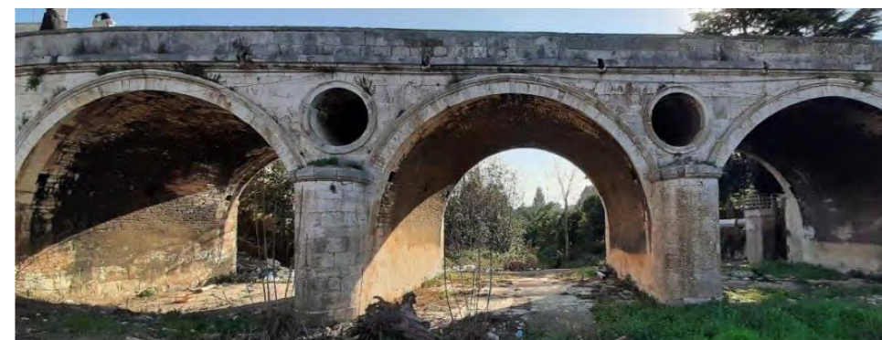
Figura 49. a- Rinfiancio alleggerito con archi (Curioni, 1871), b- Rinfiancio alleggerito del ponte Stenevasso - linea Torino-Genova, progr. 37+733 (Archivio FS - TO)
