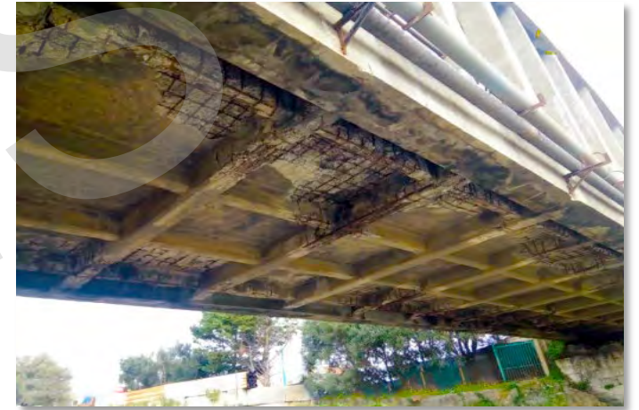
Lesioni connessione trasverso/catena
