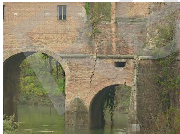
Fessurazione verticale della spalla, tipico di ponte oggetto di scalzamento fondazionale
