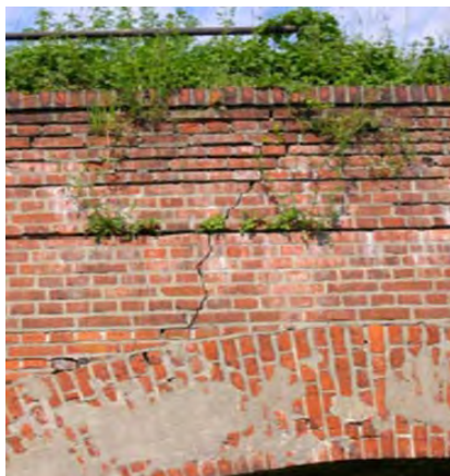
Fessurazione verticale del timpano
