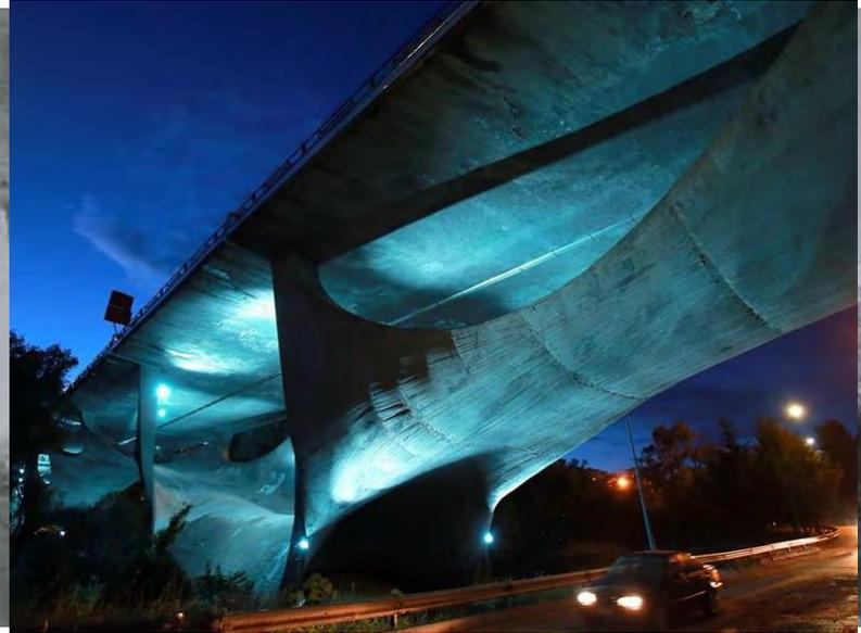
La struttura in calcestruzzo si alterna in un insieme di forme concave e convesse che disegnano quattro archi e che toccano alternativamente il suolo sotto il viale.
