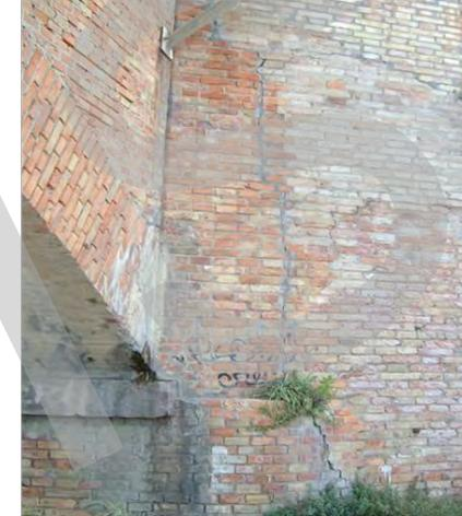
Fessurazione localizzata tra spalla e muro laterale; frequente nei ponti ad arco caratterizzati da muri laterali di una certa altezza e soggetti ad instabilità del terreno di riempimento
