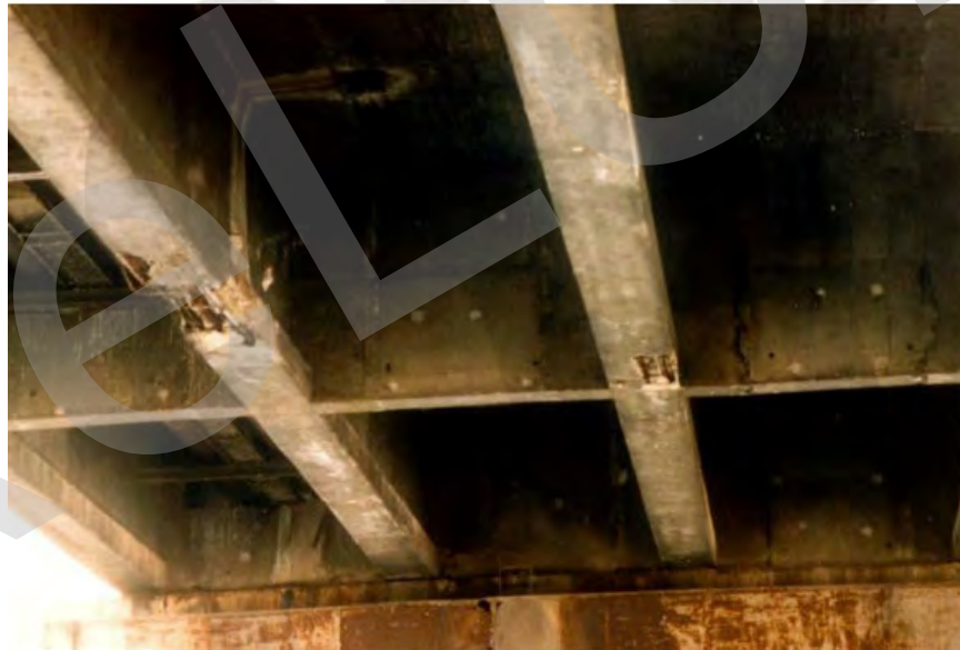
corrosione armature
