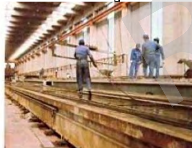
Posa in opera dell'armatura
