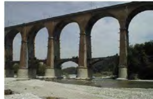
Figura 25. Viadotto Sruza - linea Fossano-Ceva, prog. 2-606 (archivio FS-TO)
