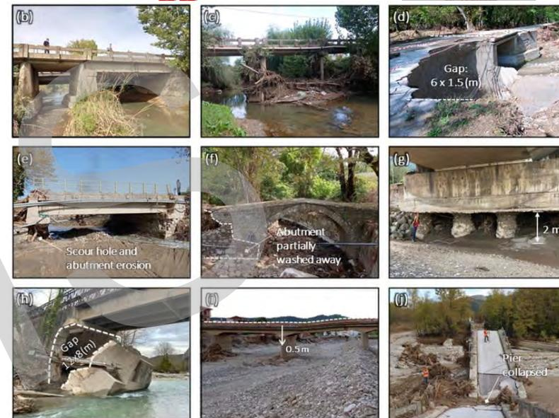
I rischi di scalzamento pile o sormonto impalcato sono indipendenti dal tipo di impalcato quindi possono essere trattati in modo trasversale. Oltre al contesto idraulico possono dipendere dal tipo di pile, spalle e fondazioni
