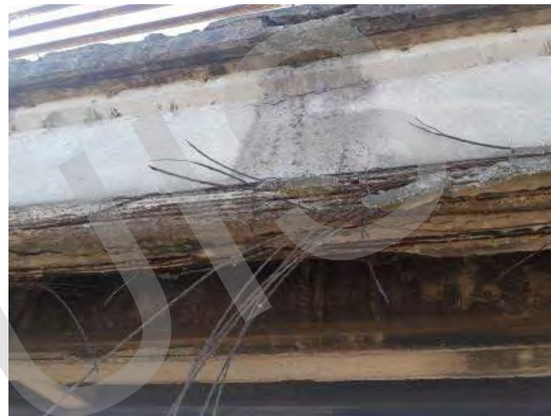
Riduzione armatura da precompressione
