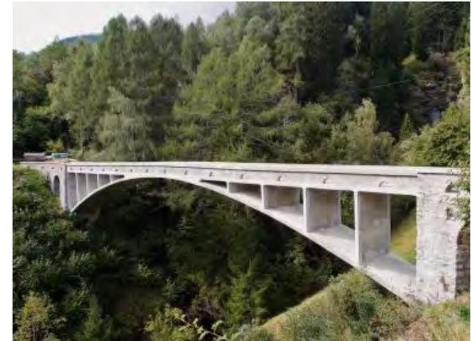
L'arco è la prima forma che si utilizza passando dalla muratura al cemento armato che presenta buone prestazioni in compressione . A volte molto ribassato con spinte molto elevate
