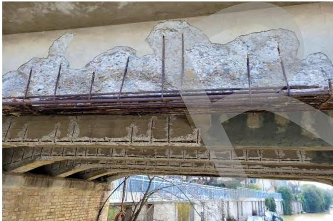
**Armatura longitudinale deformata**
