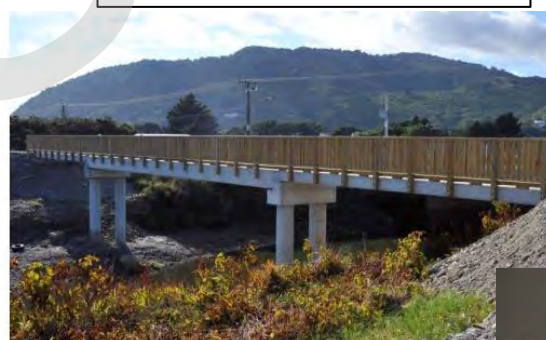
Pila a telaio
