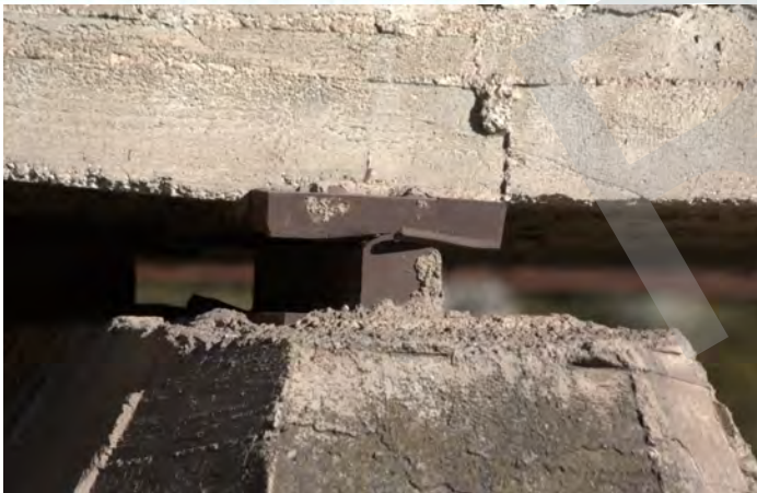
Piastra superiore deformata
