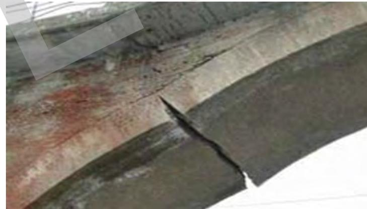
Fessurazione alternata dell'arco nell'intradosso e nell'estradosso in quattro punti localizzati (4 CERNIERE), interessa la singola campata. Si può verificare in qualsiasi tipo di ponte, in particolare è frequente negli archi di spessore ridotto e con volte ribassate.
