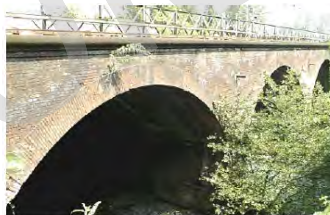
Figura 15 Muro andatorio o timpano. Si osservi il coronamento in pietra a taglio (ponte Dora - linea Torino-Milano, progressiva 5-915 - Archivio FS-TO).
