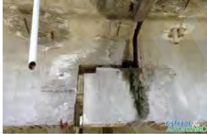
Degrado apparecchi di appoggio
