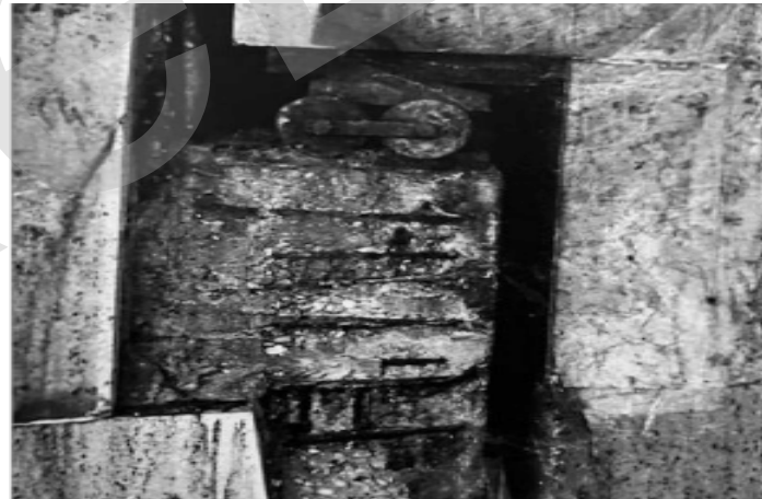
Degrado apparecchi di appoggio
