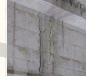
Da 2 a 3: Avanzamento fase di propagazione e di perdita di sezione trasversale armatura accompagnati da fessure di splitting lungo lo sviluppo delle armature e perdita di copriferro
