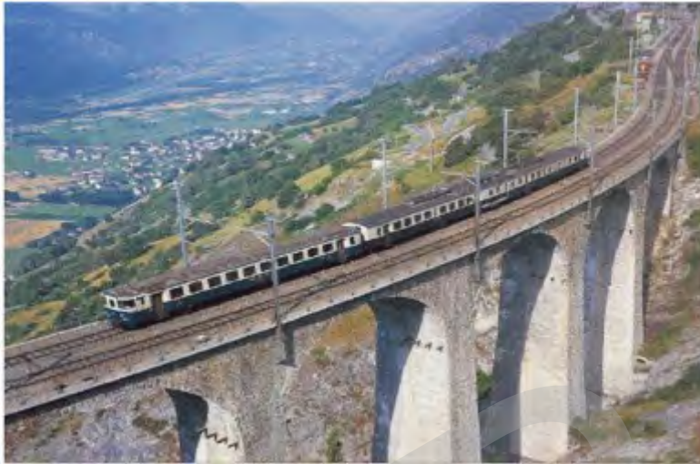
Viadotto in curva ad un solo ordine (viadotto Luogelkinnenviadukt, Svizzera).
