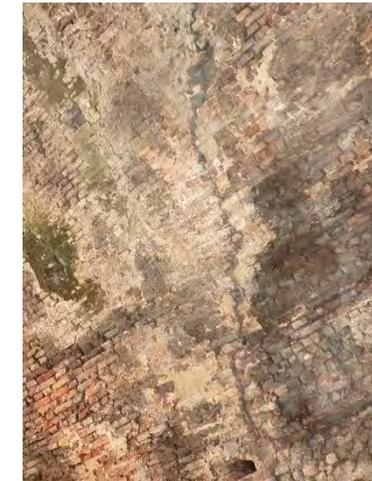
Fessurazioni lungo la parte centrale della volta, frequente nei ponti in muratura con asimmetria del carico dei binari rispetto all'asse.
