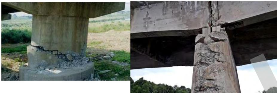
Nel rischio sismico la vulnerabilità della struttura dipende dallo schema statico e dalla capacità degli elementi portanti verticali. Per gli impalcati in precompresso può essere importante l'effetto di sisma verticale
