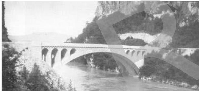
Figura 48. Rinfianchi alleggeriti da archi secondari, ponte sul Rodano a La Balme (Grattesat ed., 19
