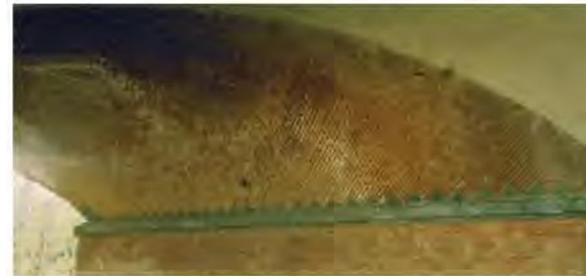
Figura 3 Tessitura elicoidale, ponte Borbore - linea Torino-Genova, progr. 54+797 (Archivio FS - TO)
