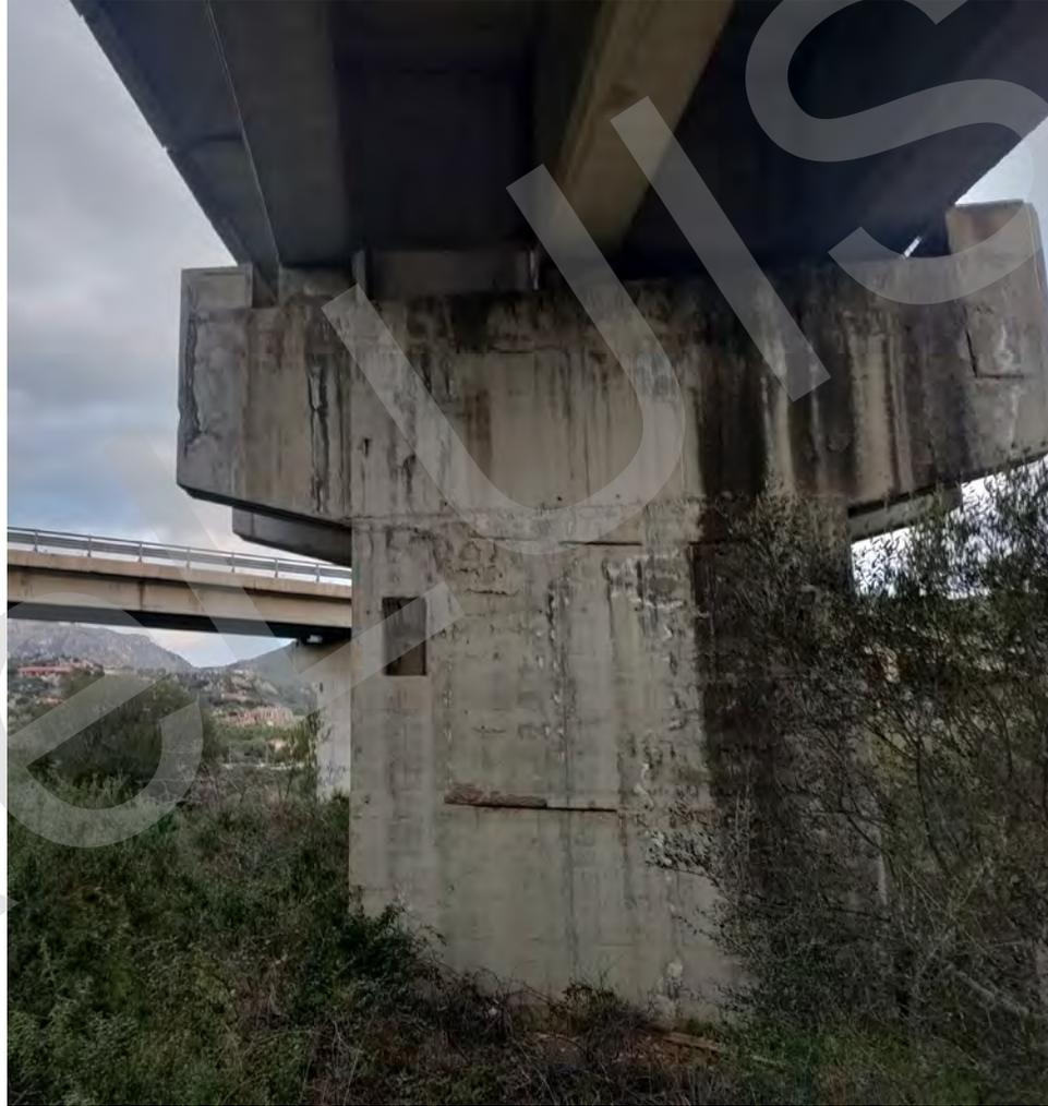
Tali problematiche sono solitamente correlate ad una non corretta regimentazione delle acque con conseguenti infiltrazioni provenienti dall'impalcato che vanno ad insistere sui pulvini, dispositivi di appoggio e pile.
