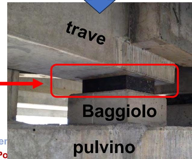
I dispositivi di appoggio sono gli elementi di connessione tra la sovrastruttura (ossia l'impalcato) e la sottostruttura (pulvino/pile/spalle)
