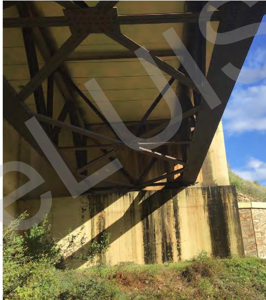
Anche le spalle possono essere interessate da infiltrazioni e dilavamenti che portano con conseguente sviluppo di fenomeni di degrado più o meno evidenti.
