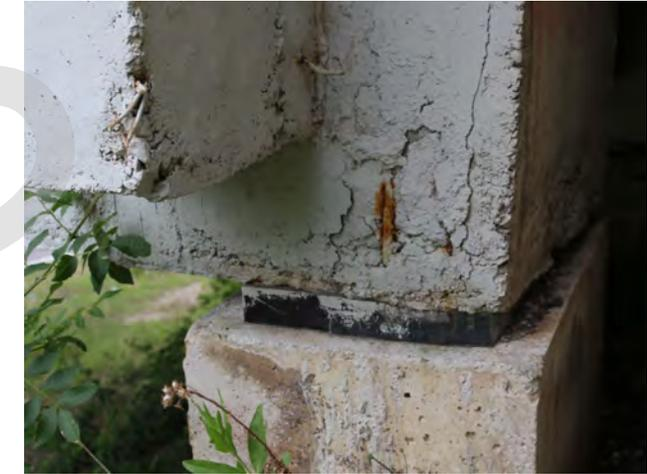
Gli appoggi in elastomero armato sono costituiti da strati di gomma e piastre di acciaio alternate. Gli appoggi in elastomero semplice sono privi di piastre orizzontali e furono utilizzati per un periodo limitato fino all'introduzione degli appoggi armati aventi prestazioni nettamente migliori
