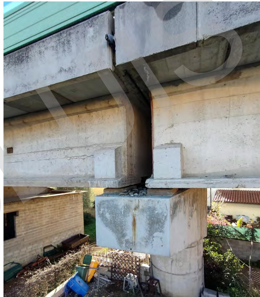
Le infiltrazioni provenienti dall'impalcato possono portare all'evoluzione di fenomeni di degrado interessanti i pulvini oltre che le pile ed i dispositivi di appoggio.
