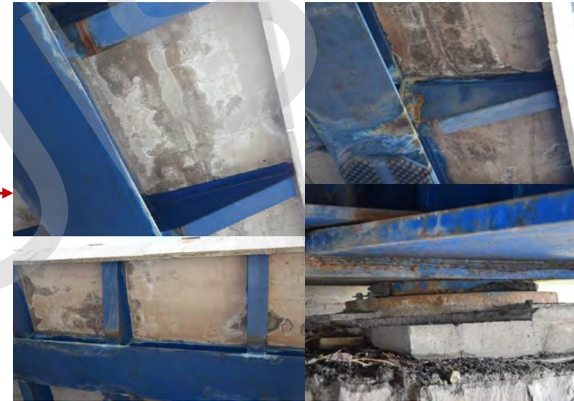
Percolazione attraverso le cavità derivanti dalle travi estradossate
