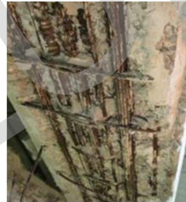
Guaine degradate e fili ossidati c.a.p._7
