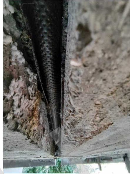
Giunto di dilatazione visto dal basso
