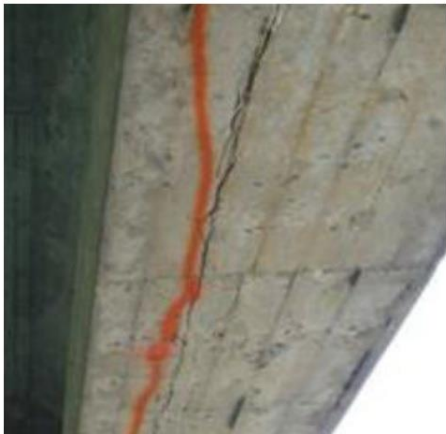
Lesioni lungo suola del bulbo c.a.p._5
