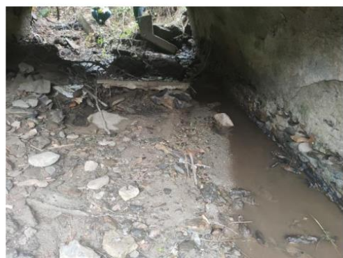
S2_Ril/Fond_1b_1: Scalzamento.
