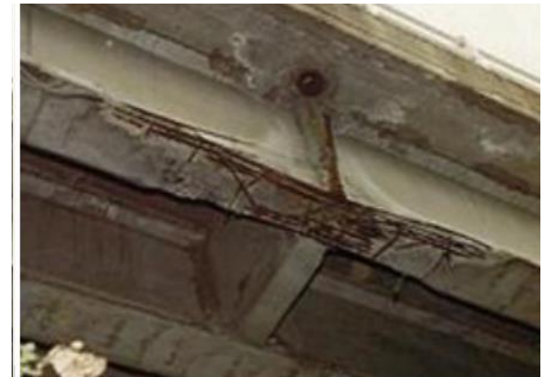
Riduzione armatura di precompressione c.a.p._9
