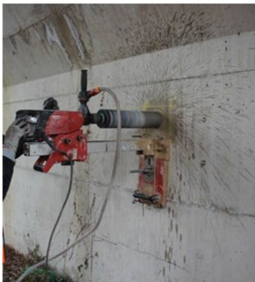
Estrazione del provino e Prove di compressione sulle carote di calcestruzzo
