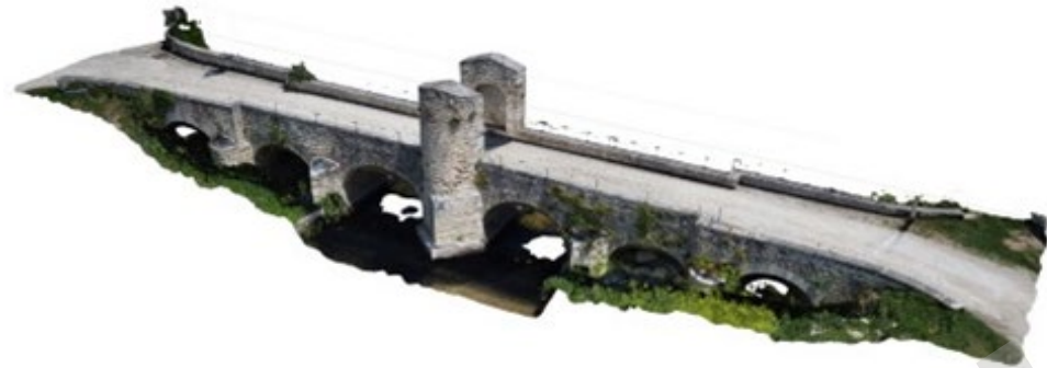
1. Nuvola di punti da laser scanner terrestre (TLS)
