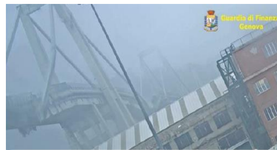
Crollo del ponte Morandi con 43 morti
