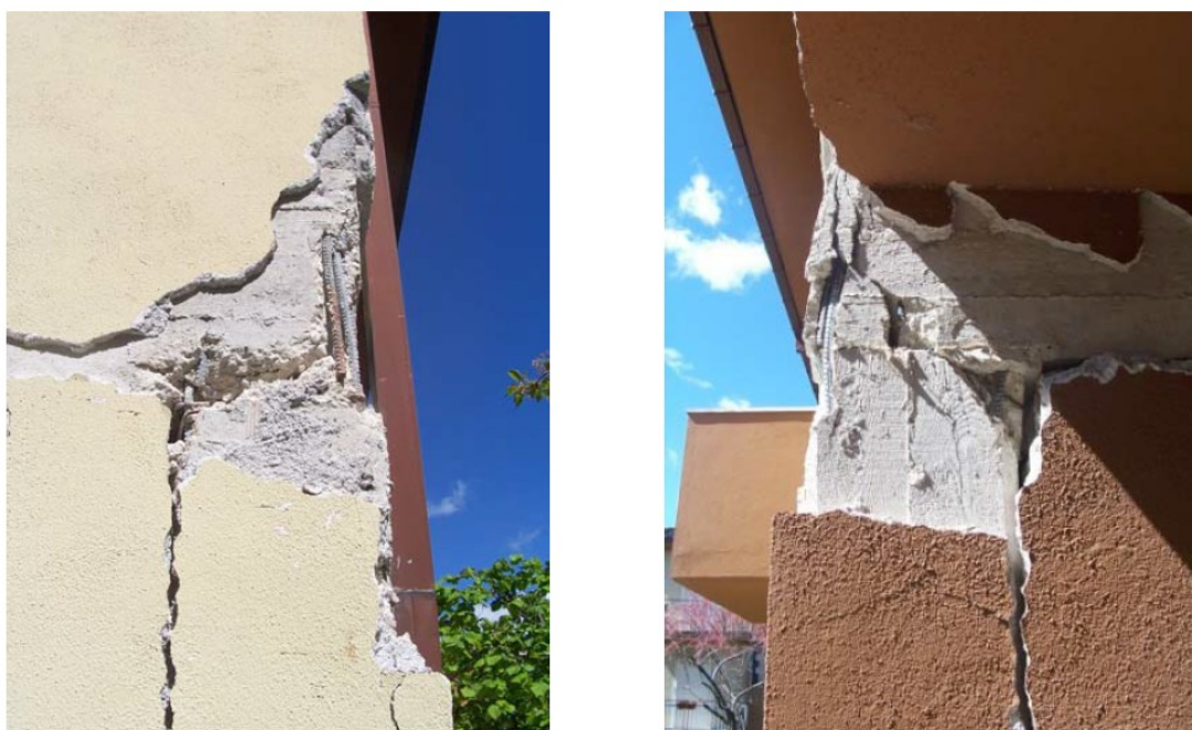
Figura 0-1: Crisi dei nodi trave-pilastro in c.a. a seguito dei recenti eventi sismici
