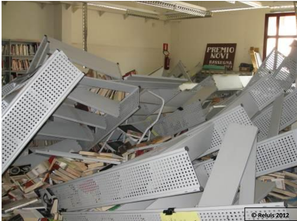
Figura 10 – Biblioteca di Novi di Modena: collasso di arredi e altri elementi non strutturali.
