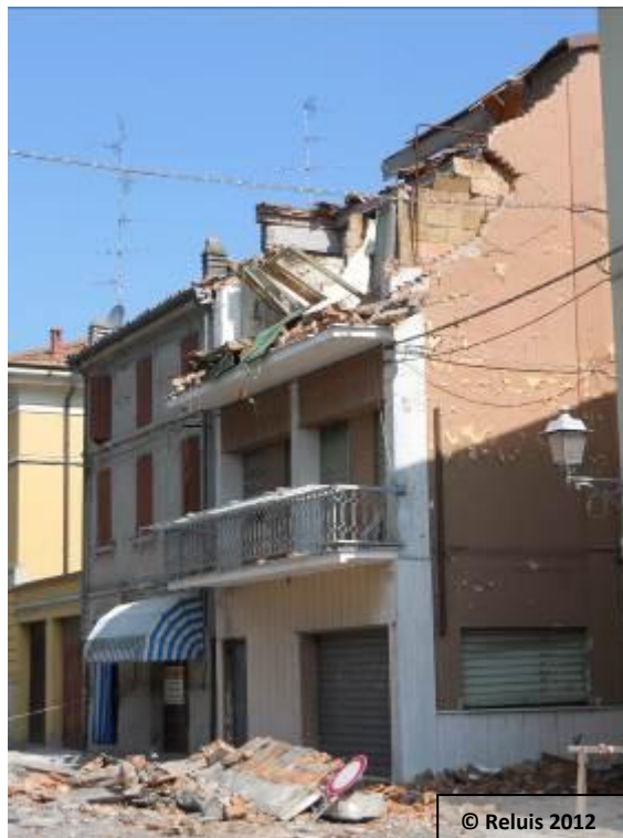
Figura 23 – Centro di Novi di Modena (MO), edificio privato: collasso della copertura.
