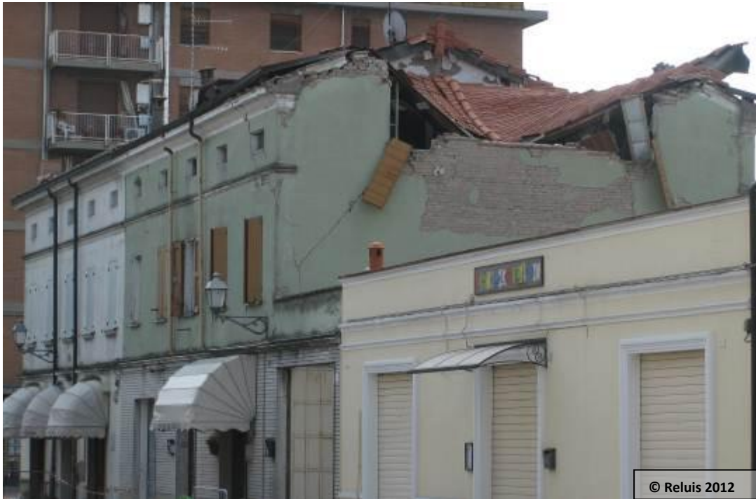
Figura 22 – Centro di Novi di Modena (MO), edificio privato: collasso parziale della copertura.
