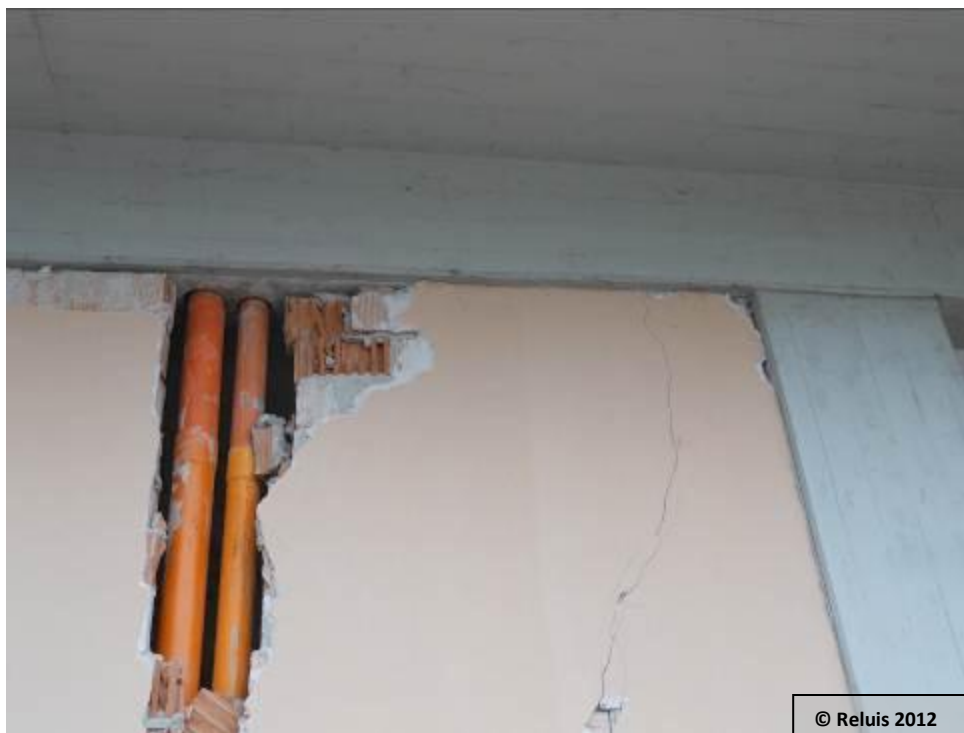
Figure 24 e 25 – Novi di Modena (MO), edificio privato; interferenza tra impianti e struttura.
