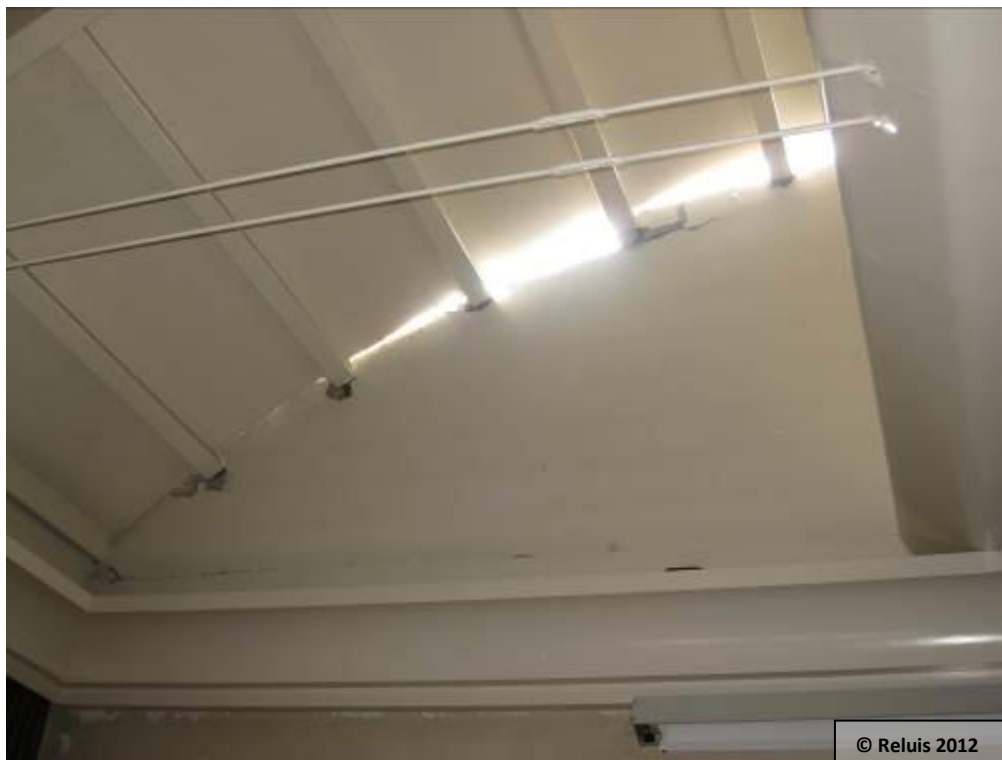
Figura 9 – Biblioteca di Novi di Modena. Copertura in legno lamellare della sala convegni: parziale perdita di appoggio delle travi secondarie. Danni da interferenza tra catene e controsoffittatura.
