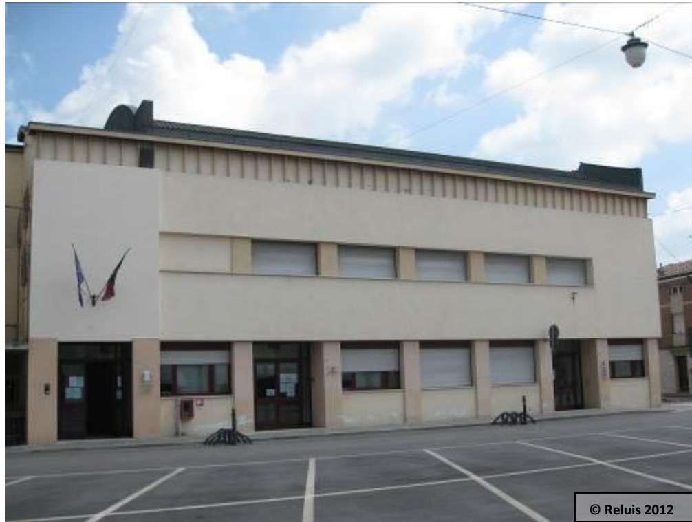
Figura 6 –Edificio polifunzionale (sede del Consiglio Comunale e della Biblioteca di Novi di Modena).
