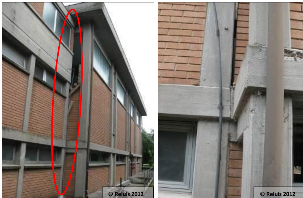
Figura 17 – Scuola Elementare “Anna Frank”, Novi di Modena (MO): dettaglio esecutivo dell’interfaccia (giunto) tra 2 corpi di fabbrica autonomi
