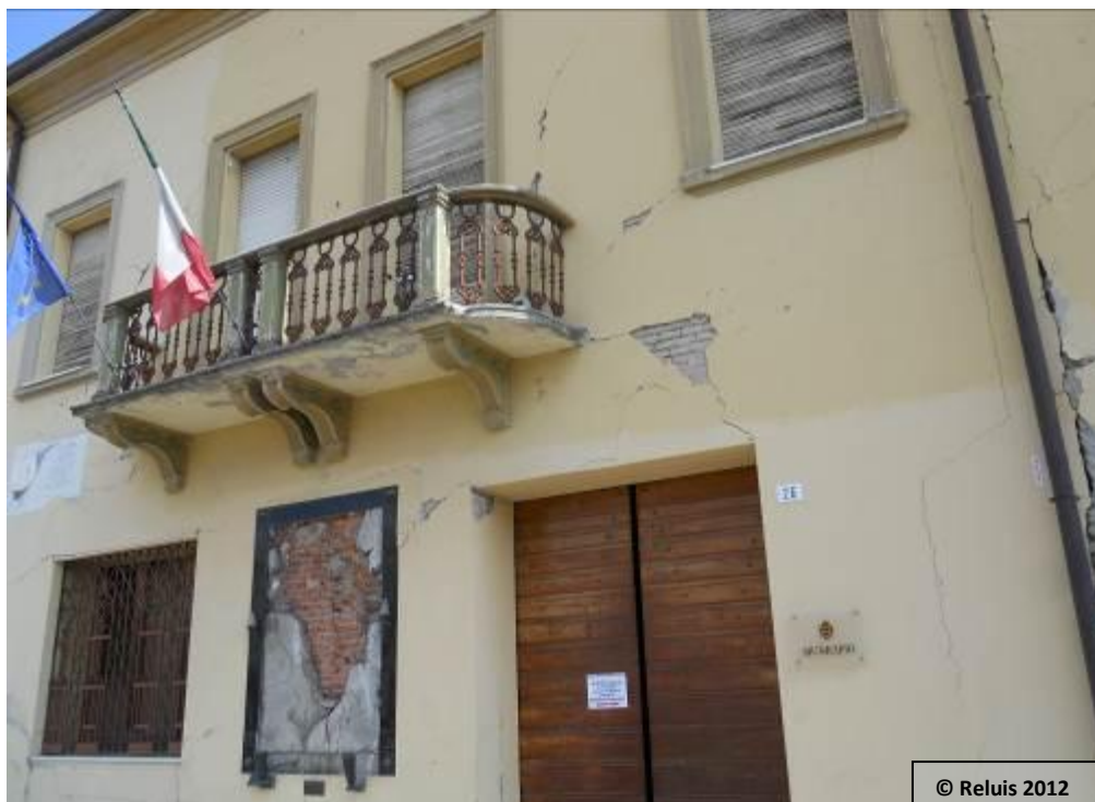
Figura 5 – Municipio di Novi di Modena (MO), piazza I maggio: diffuse lesioni alle pareti murarie; crollo della lapide posta sul prospetto principale.
