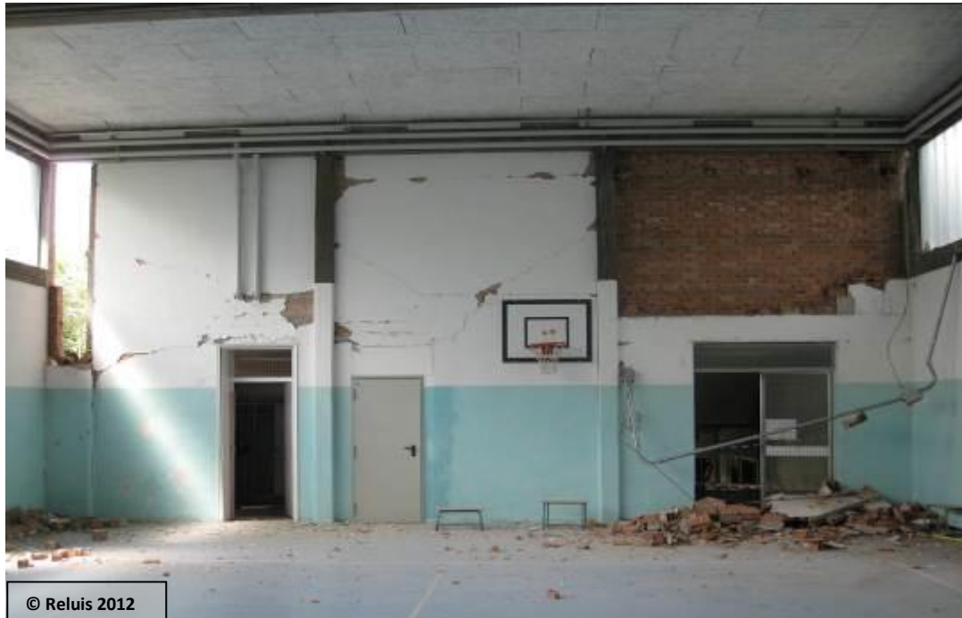
Figura 18 – Scuola Elementare “Anna Frank”, Novi di Modena (MO): ampio quadro fessurativo e collasso parziale della tamponatura presente nel locale palestra.
