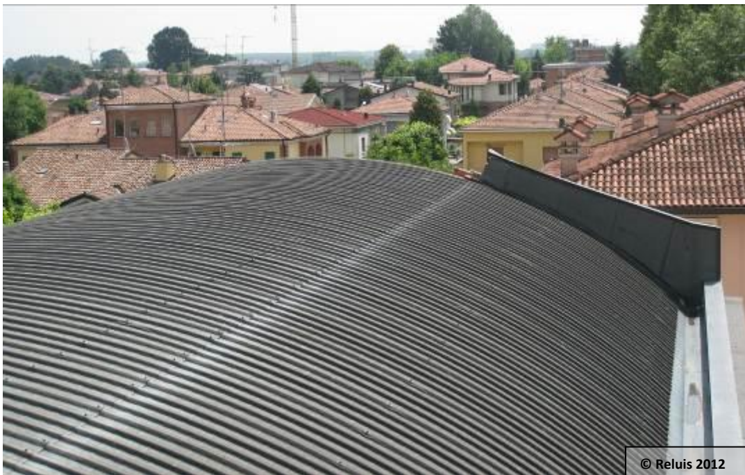
Figura 7 – Biblioteca di Novi di Modena, piazza I maggio: parziale collasso del parapetto di chiusura della copertura in legno lamellare.
