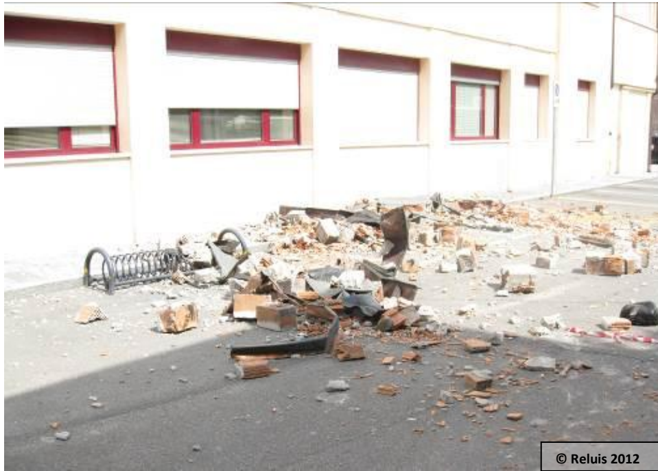
Figura 8 – Biblioteca di Novi di Modena (MO), piazza I maggio: parapetto copertura collassato.
