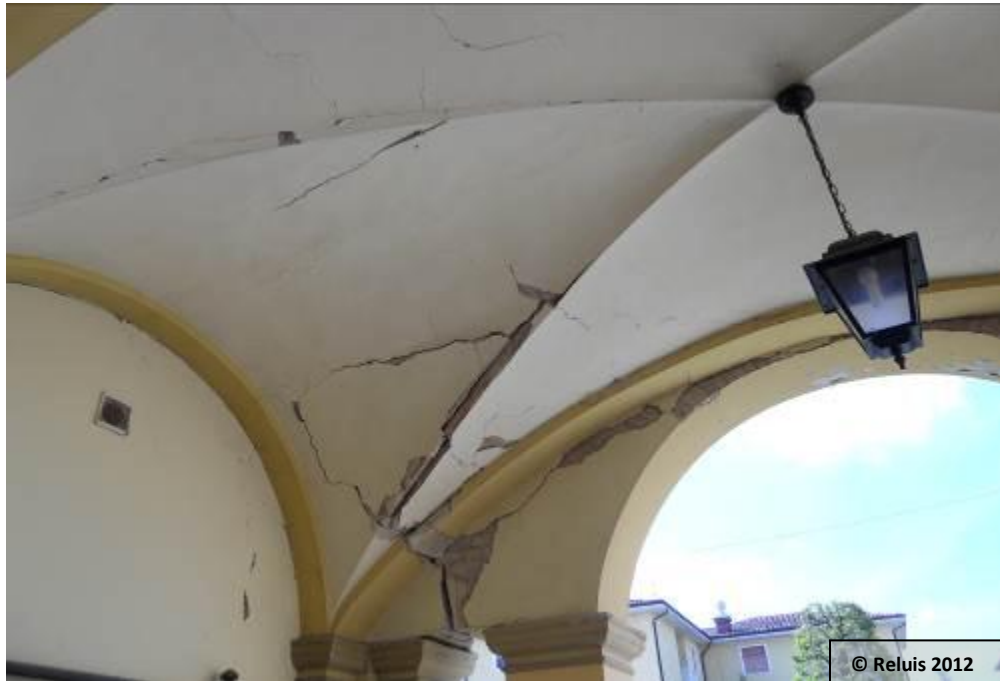
Figura 4 – Municipio di Novi di Modena (MO), piazza I maggio: danneggiamento delle volte murarie.
