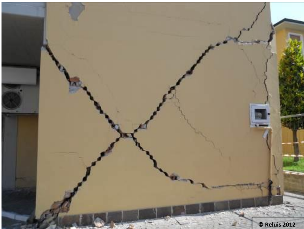
Figura 21 – Centro di Novi di Modena (MO), edificio privato: diffusa crisi per taglio dei pannelli murari.
