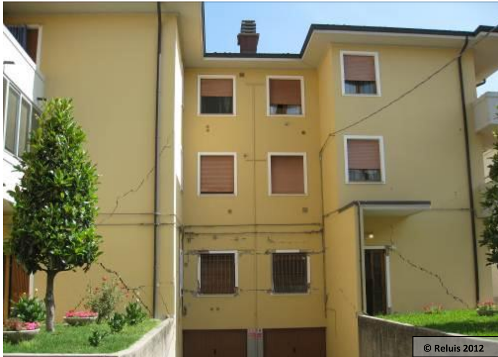
Figura 20 – Centro di Novi di Modena (MO), edificio privato: diffusa crisi per taglio dei pannelli murari.
