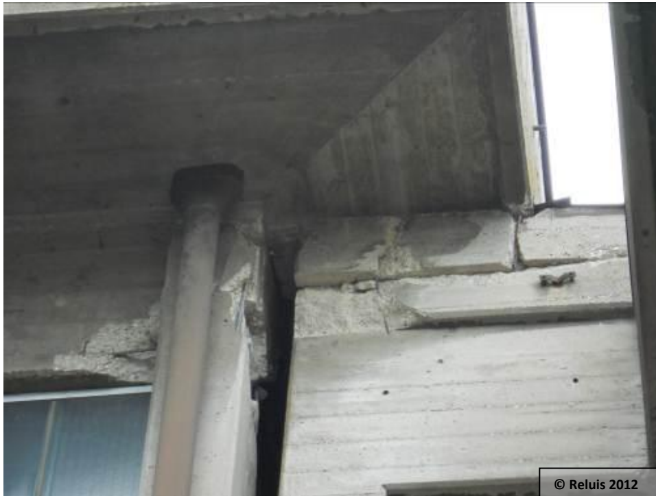
Figura 16 – Scuola Elementare “Anna Frank”, Novi di Modena (MO): danni da martellamento tra corpi di fabbrica autonomi e adiacenti.
