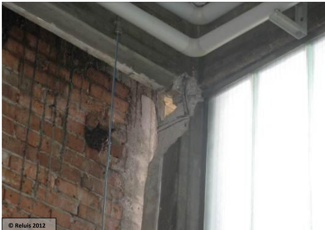
Figura 19 – Scuola Elementare “Anna Frank”, Novi di Modena (MO): crisi di un nodo trave-pilastro.
