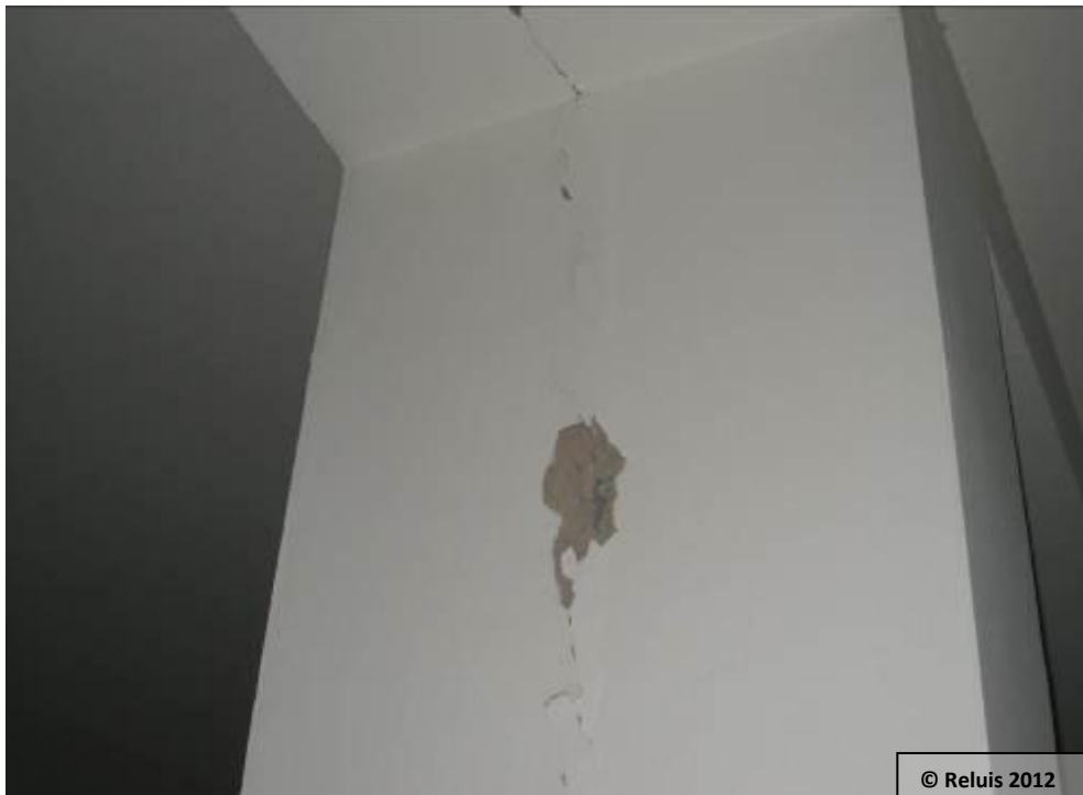
Figura 11 – Biblioteca di Novi di Modena: lesione di intonaco per apertura del giunto all'interfaccia di due pilastri in c.a. giustapposti.
