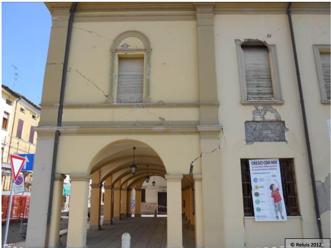
Figura 3 – Municipio di Novi di Modena (MO), piazza I maggio: diffuse crisi per taglio di pannelli murari, disallineamento degli archi murari rispetto alle colonne sottostanti.
