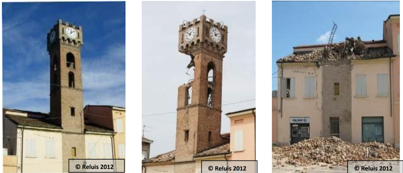
Figura 1 – Sequenza di danneggiamento della Torre dell’orologio di Novi di Modena: prima del sisma (sinistra), dopo l’evento del 29 maggio (centro), e dopo il terremoto del 3 giugno 2012 (destra).
