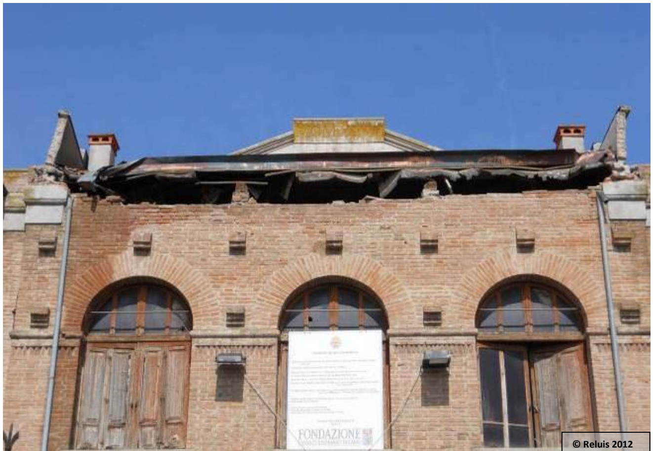
Figura 13 – Teatro di Novi di Modena (MO), viale Martiri della Libertà: parziale collasso della copertura.
