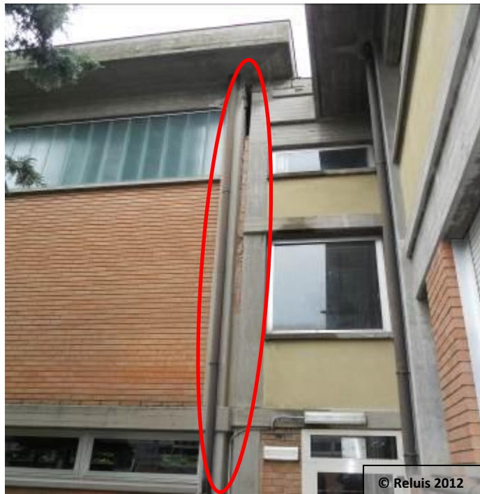
Figura 15 – Scuola Elementare “Anna Frank”, Novi di Modena (MO): dettaglio esecutivo dell’interfaccia tra 2 corpi di fabbrica autonomi (corpo principale della scuola, palestra/refettorio)
