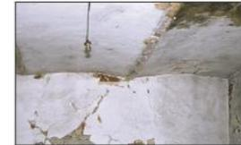
Solaio con travi di ferro a voltine.
