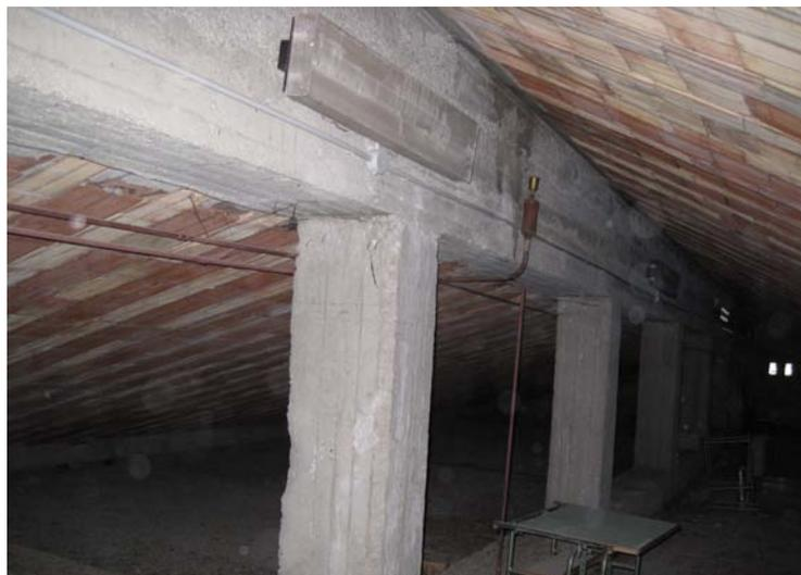
Figura 2.2. 6: Copertura in latero-cemento a due falde del blocco B.
