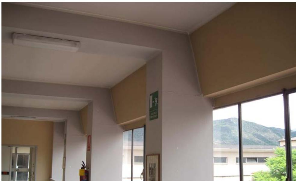
**Figura 6.2. 4:** Finestre del blocco 1 affacciate sul cortile interno, trave a veletta.
