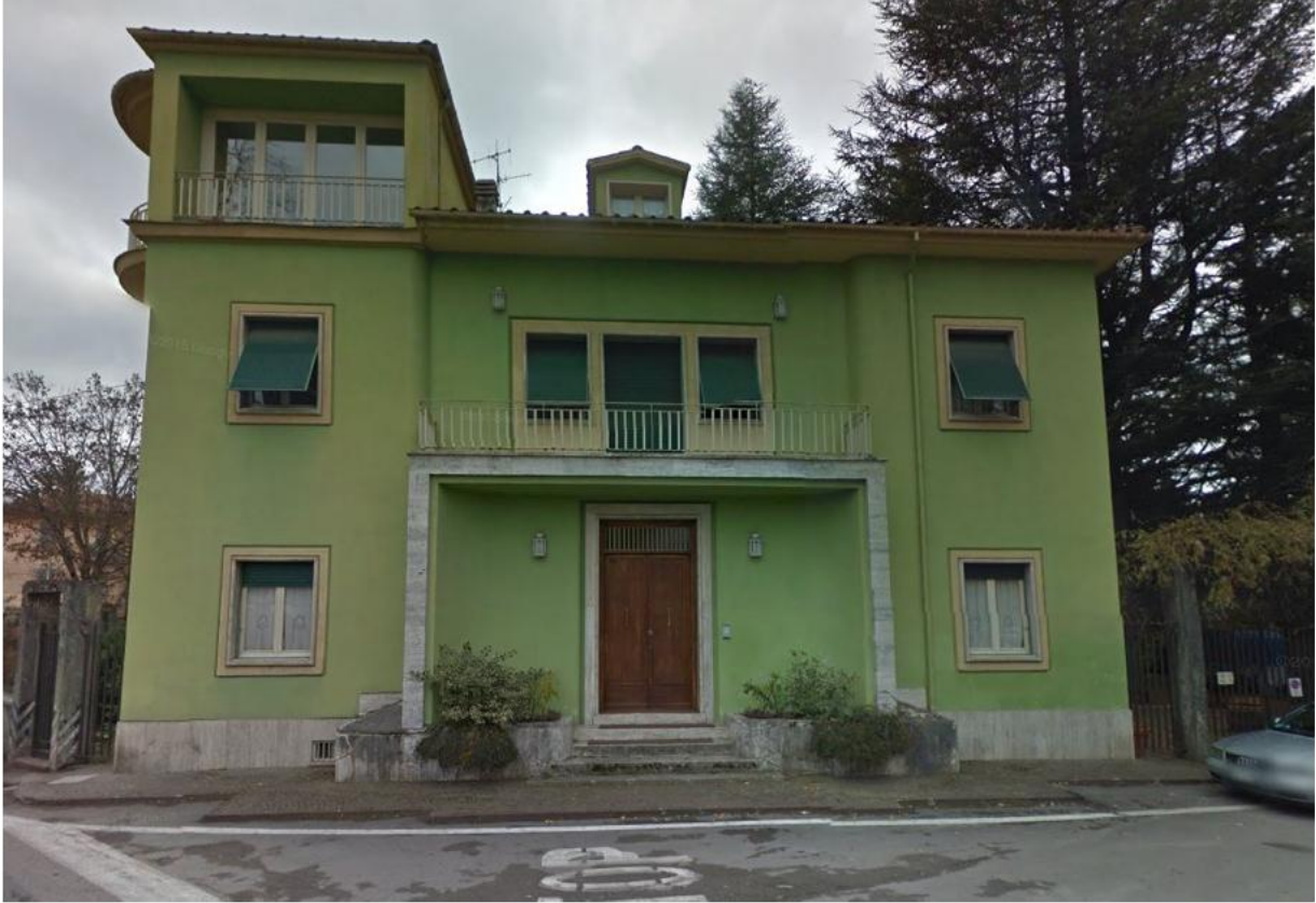
Edificio M2: muratura, 3 impalcati
