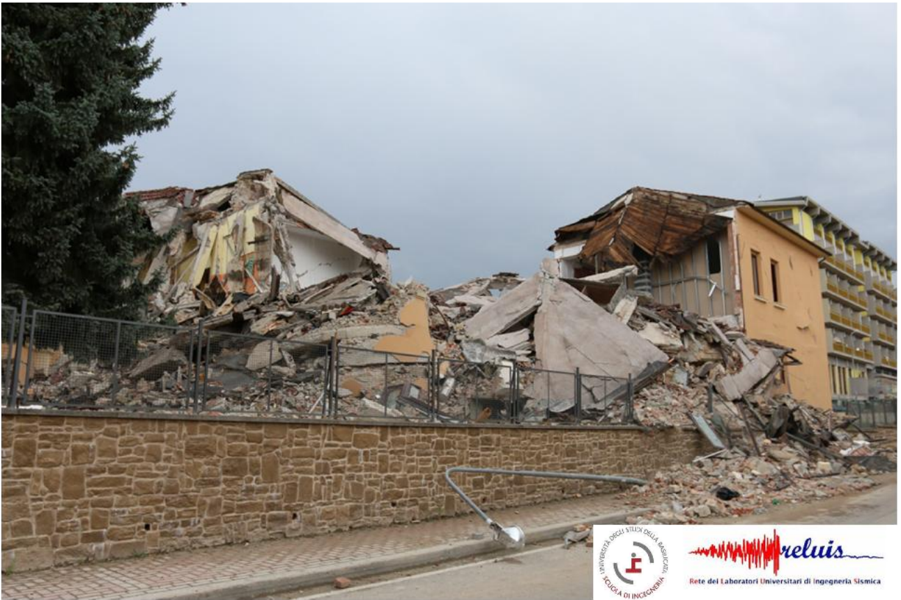
Collasso parziale del corpo in muratura
