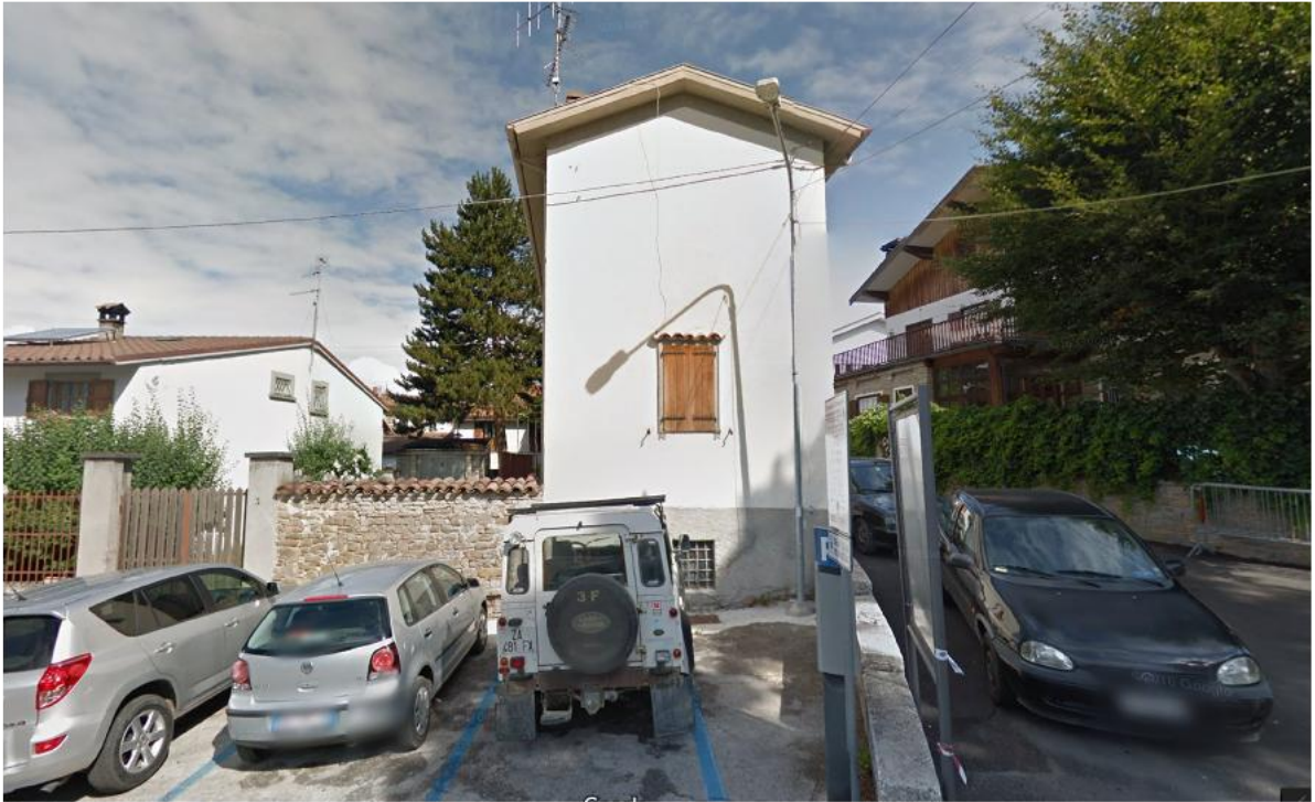
Situazione pre sisma
