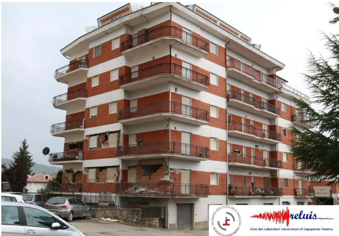
Danneggiamento diffuso alle tamponature del II e III livello
