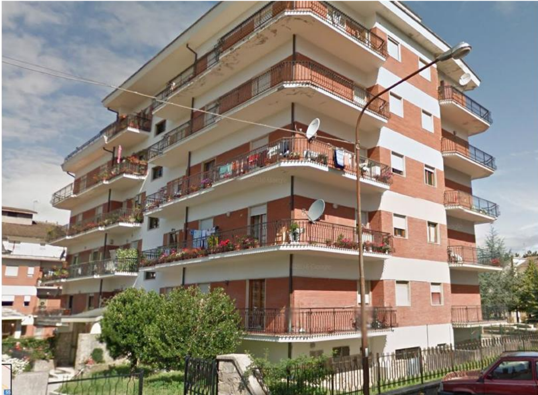
Situazione pre sisma
