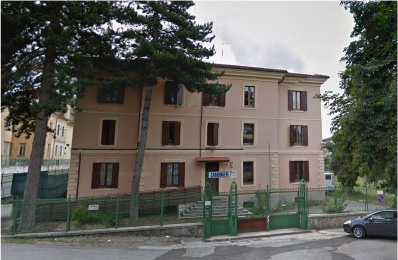
Situazione pre sisma
