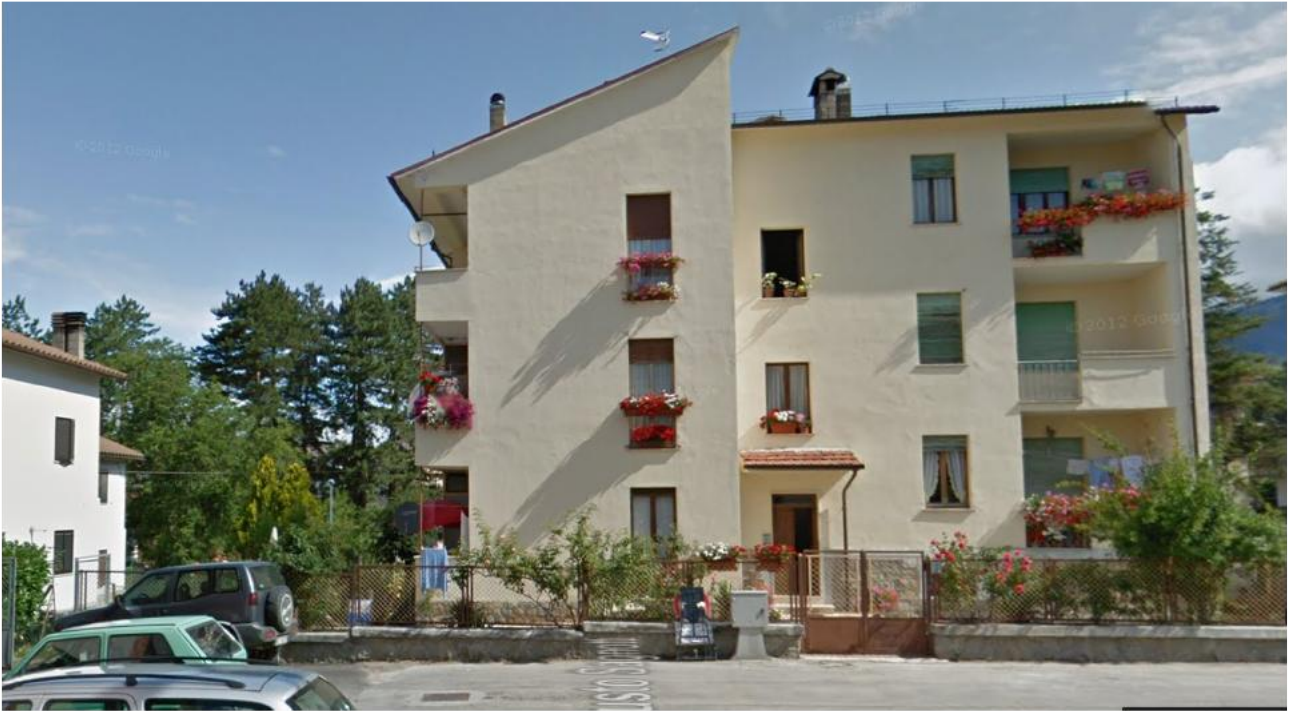
Situazione pre sisma
