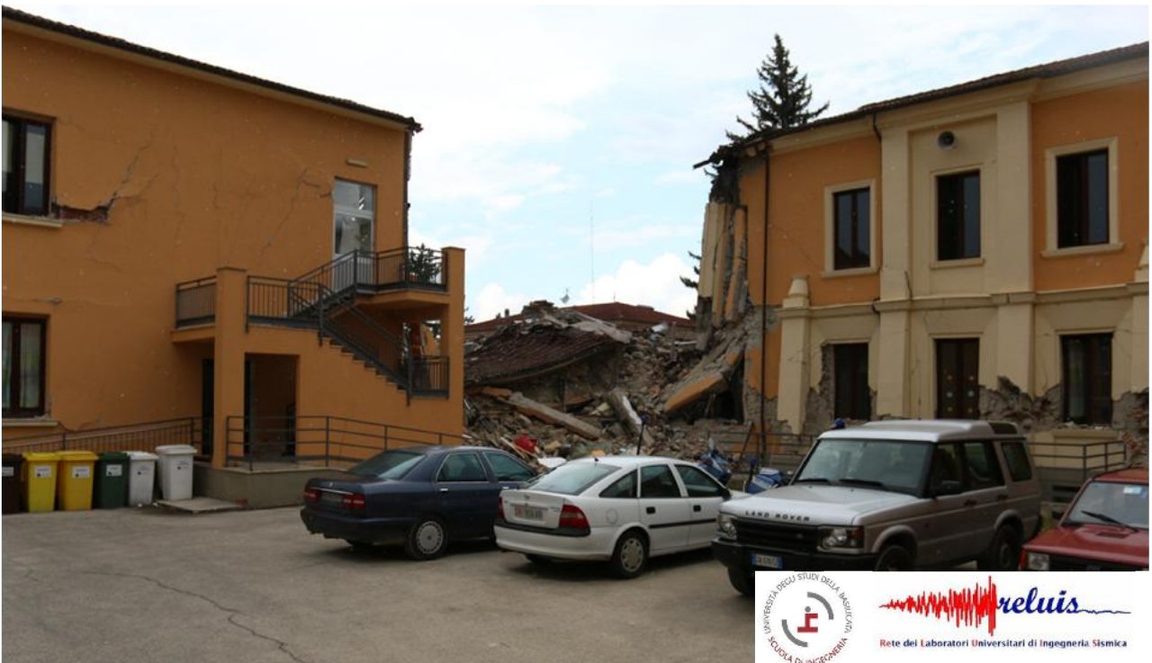
Collasso parziale del corpo in muratura (vista dal cortile interno)
