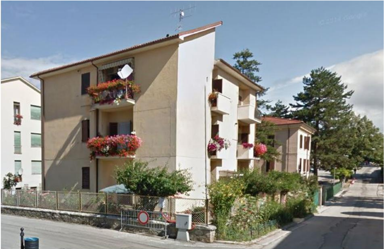
Situazione pre sisma
