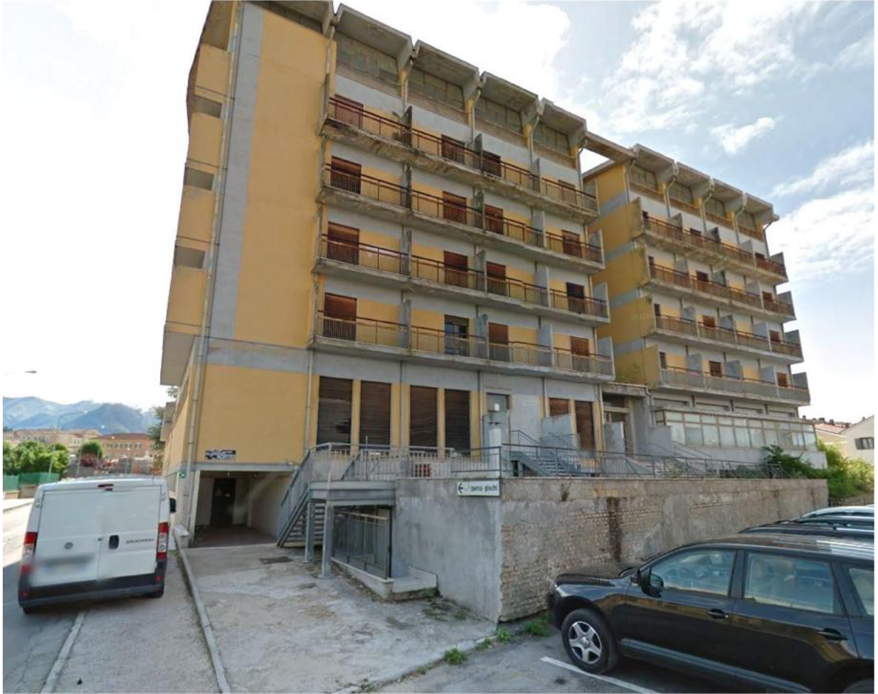
Situazione pre sisma
