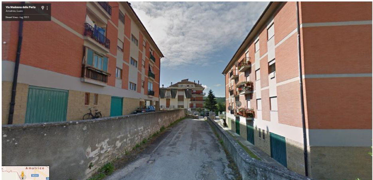
Situazione pre sisma
