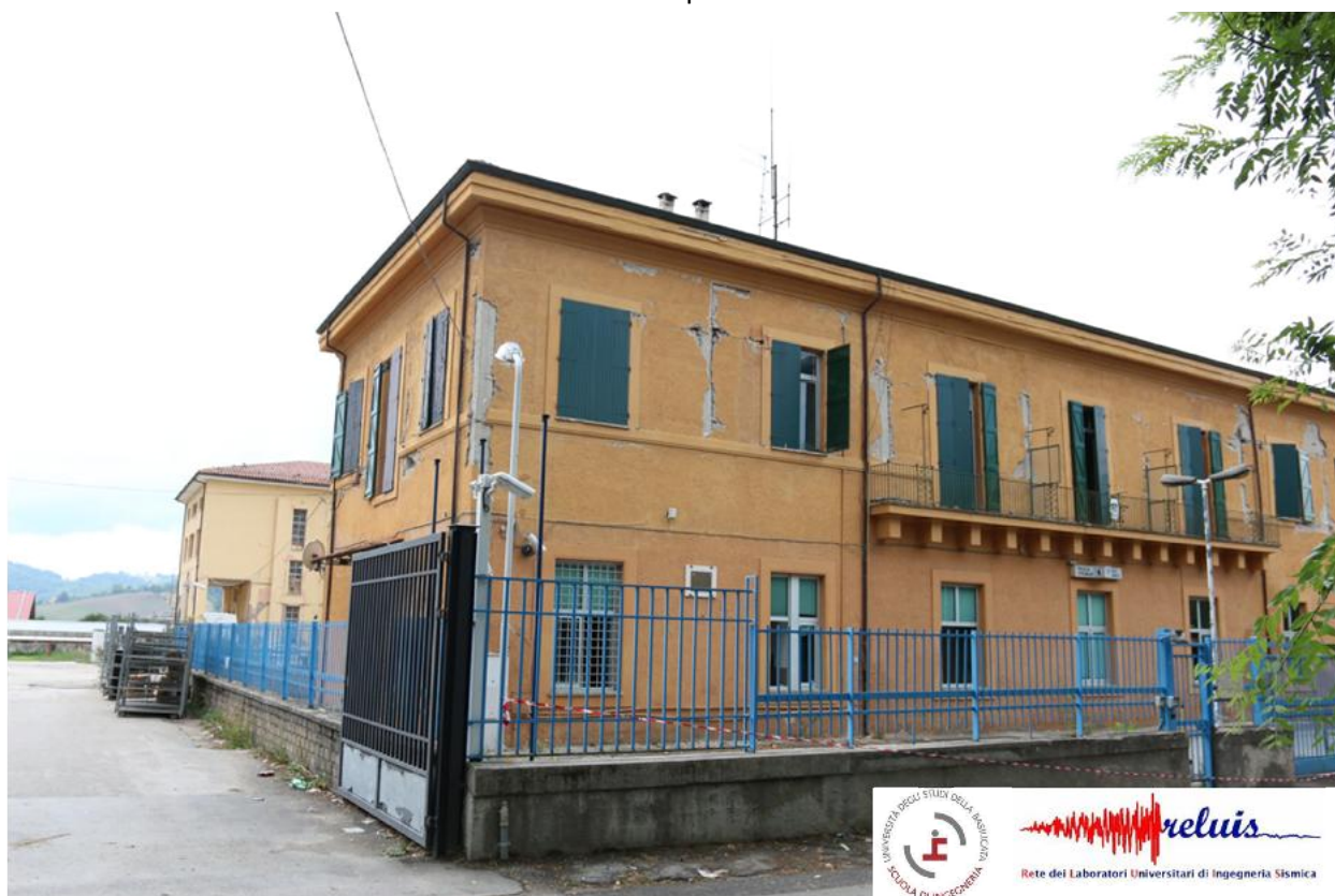
Danni alle murature, distacco dalla struttura in c.a.
