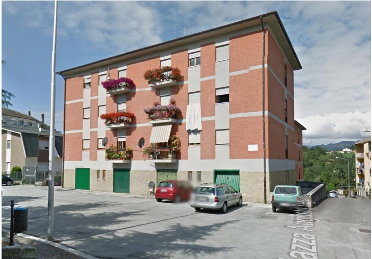
Edifici C2 e C2A : cemento armato, 4 impalcati
