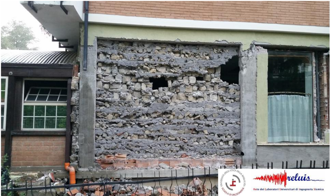
Presenza di tamponatura in pietrame avente funzione di rivestimento interno
