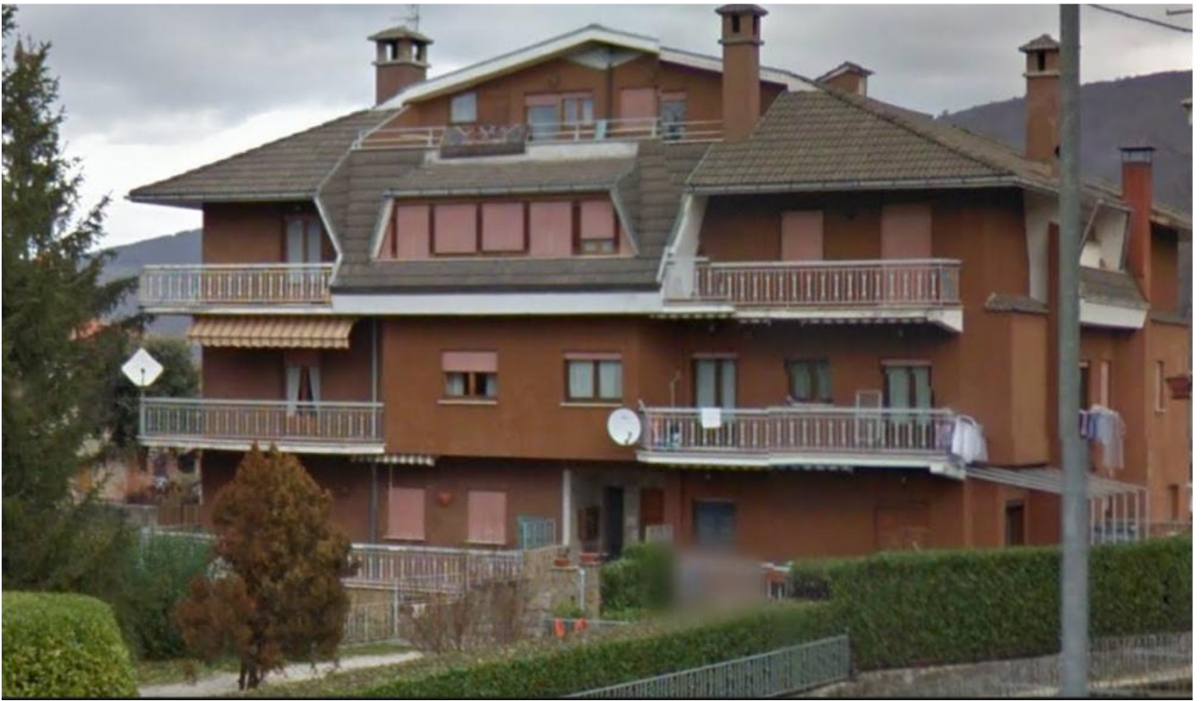
Situazione pre sisma
