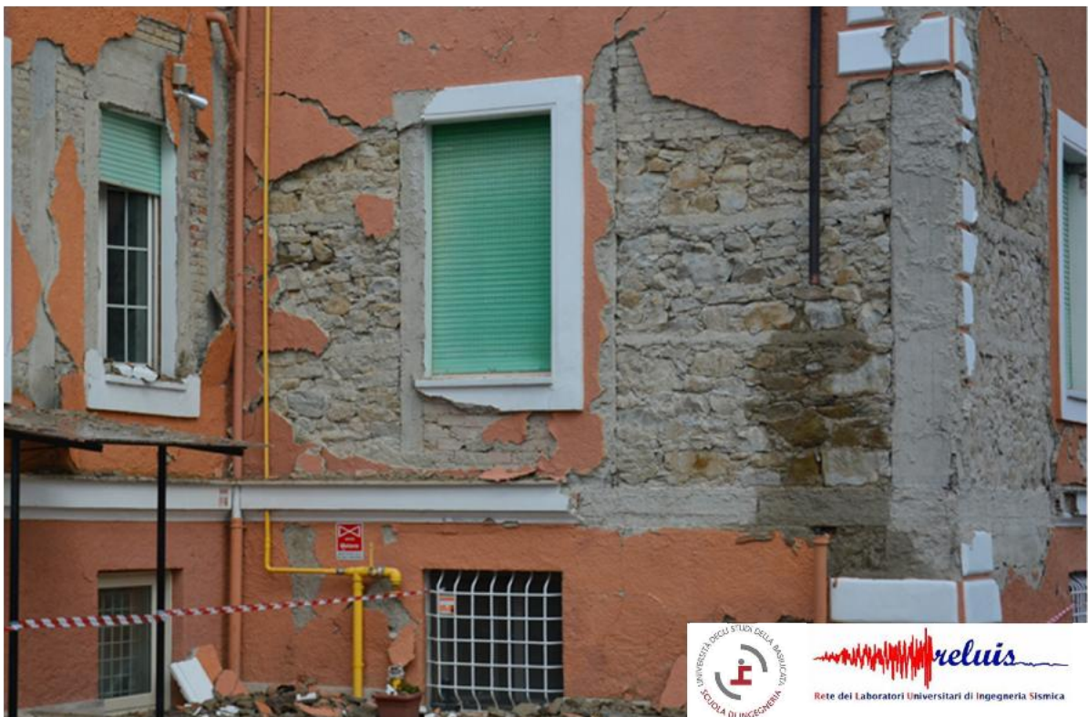
Presenza di ricorsi orizzontali di calcestruzzo nell'apparecchio murario
