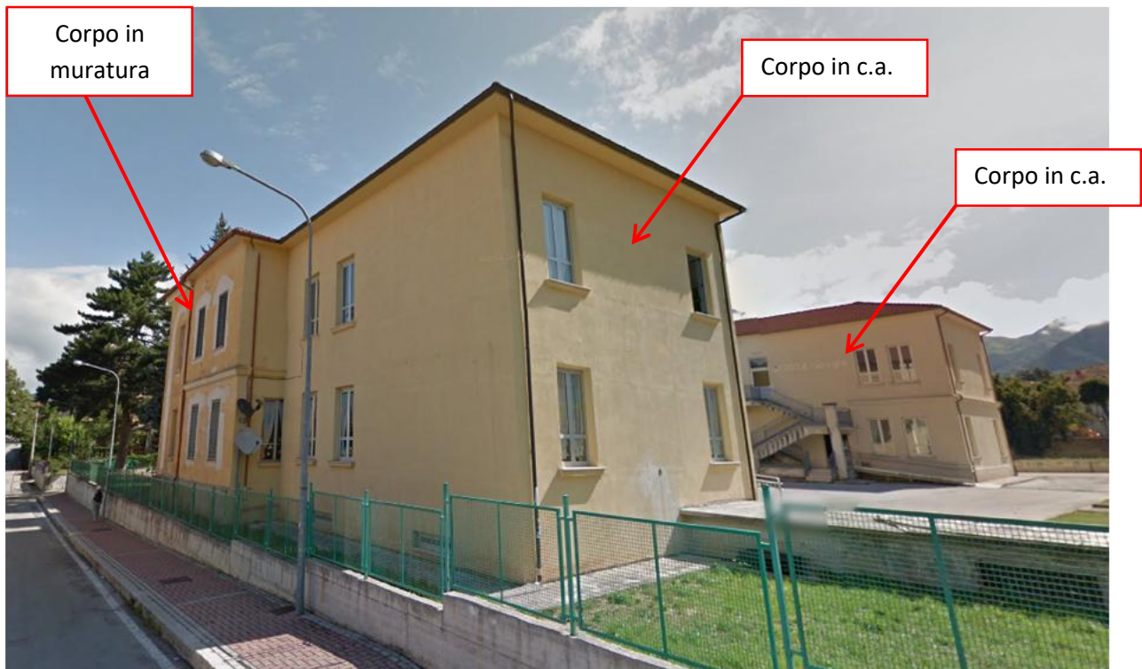
Situazione pre sisma
