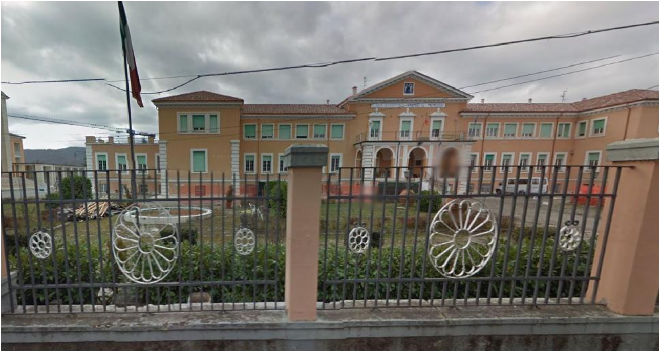
Situazione pre sisma
