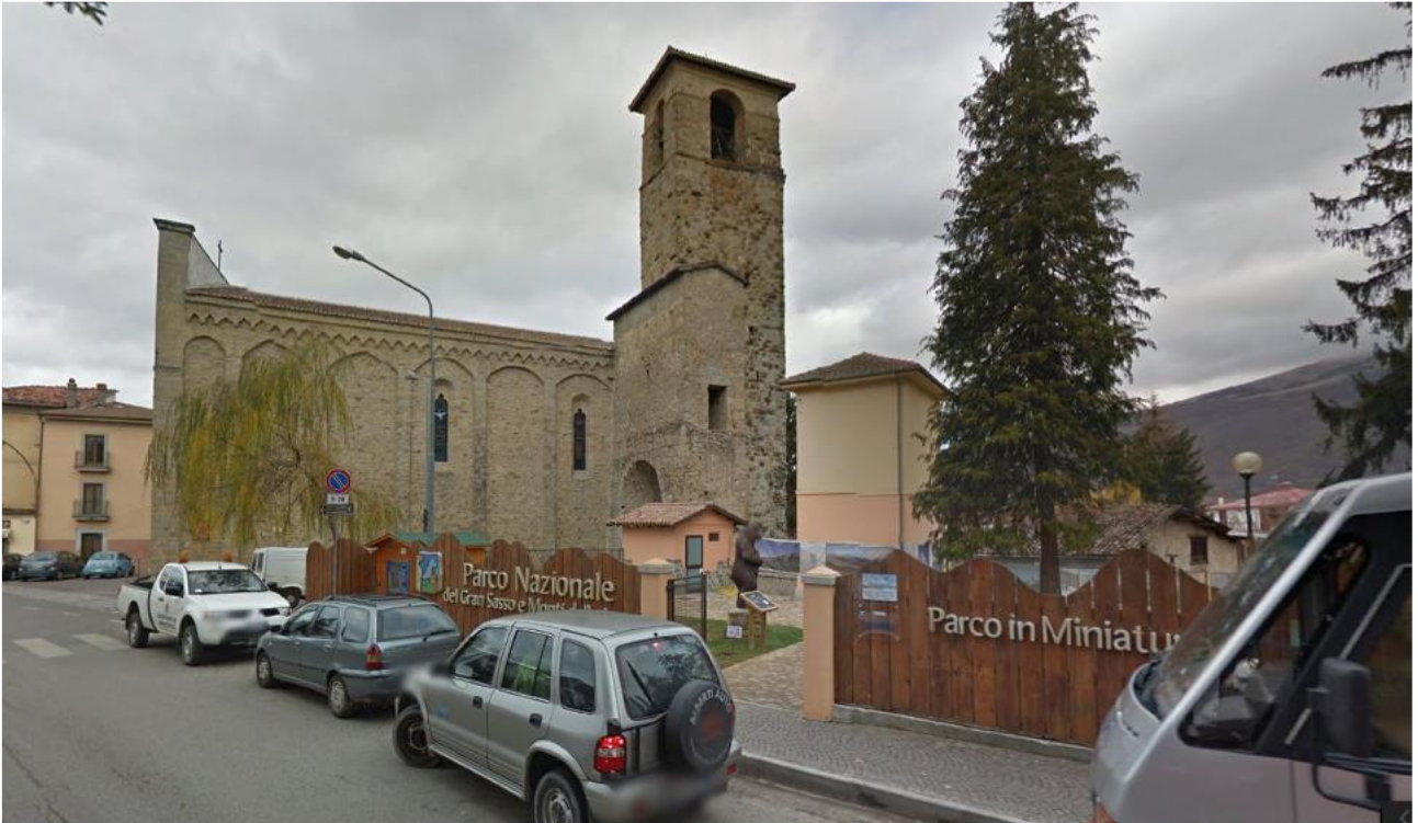
Edificio M8: muratura, 1 impalcato
