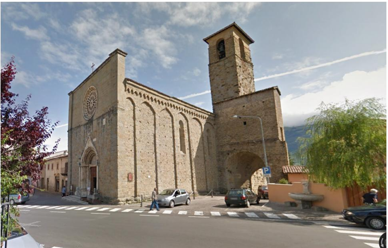
Situazione pre sisma
