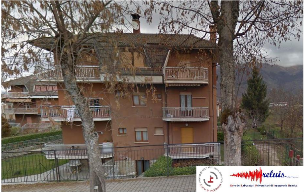
Situazione pre sisma
