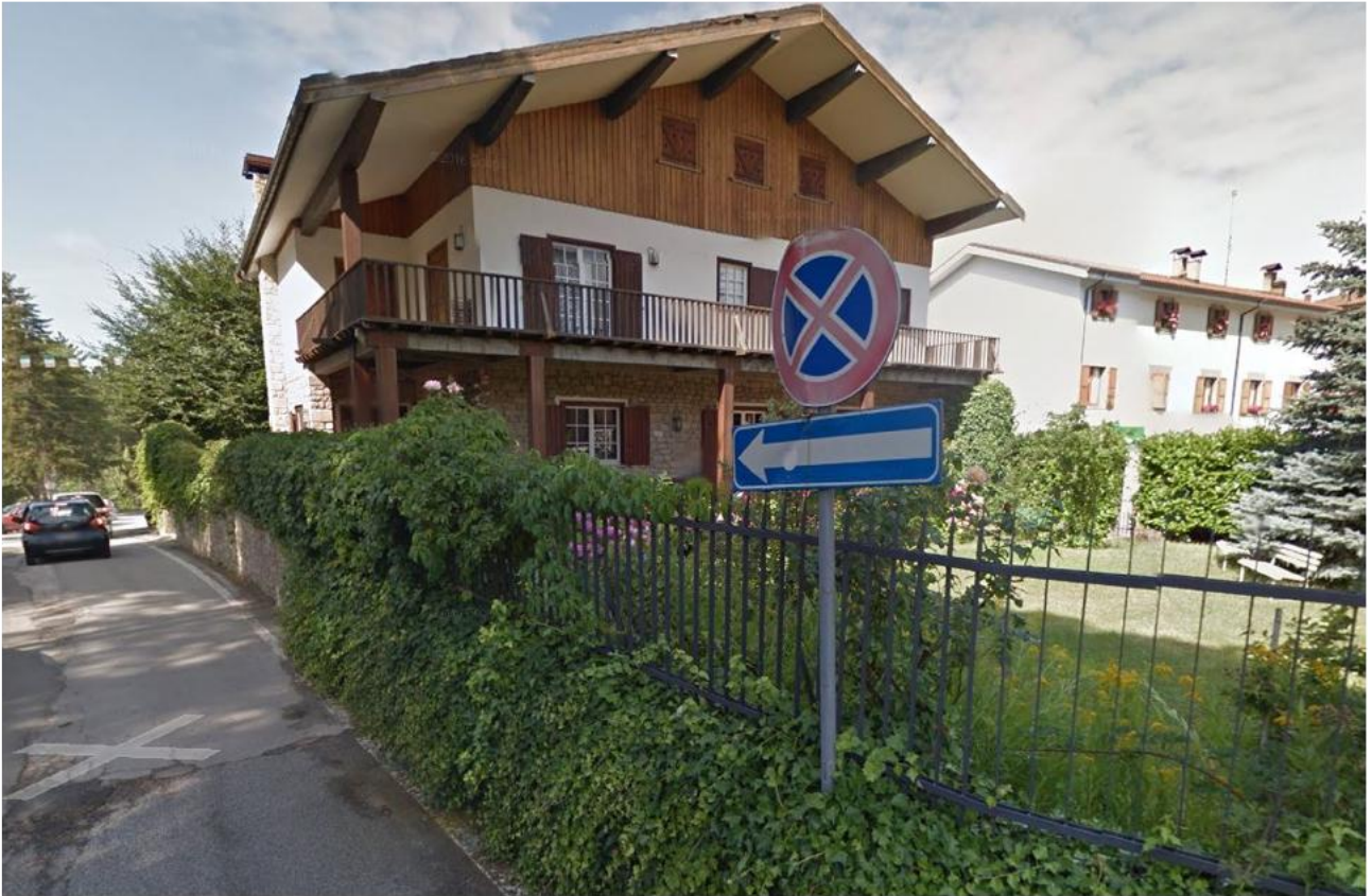
Situazione pre sisma
