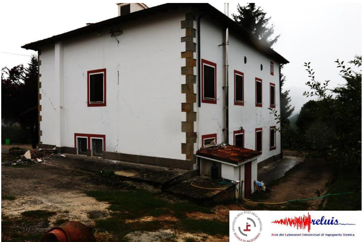
Danneggiamento nel piano dei maschi murari
