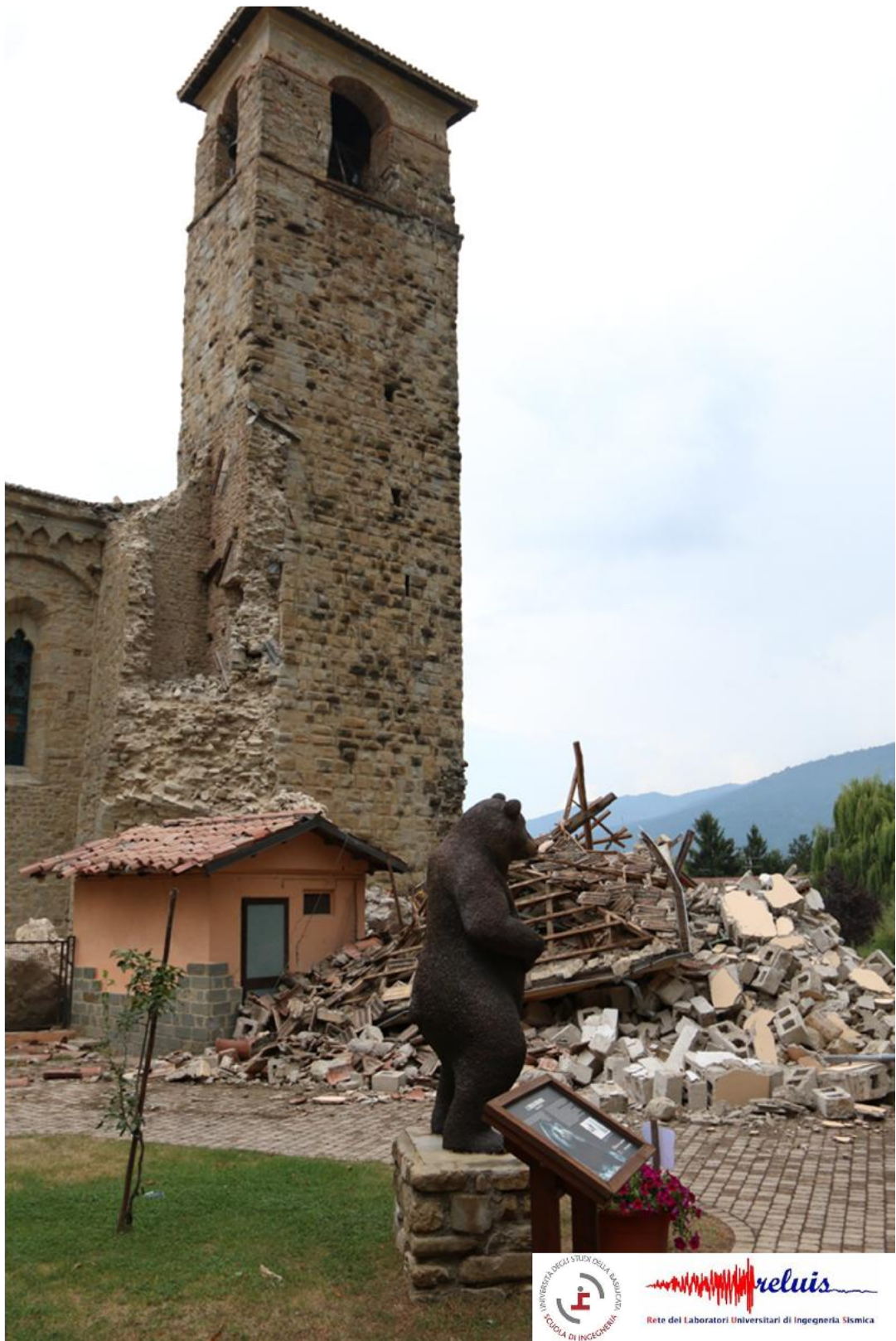
Collasso di un corpo laterale
