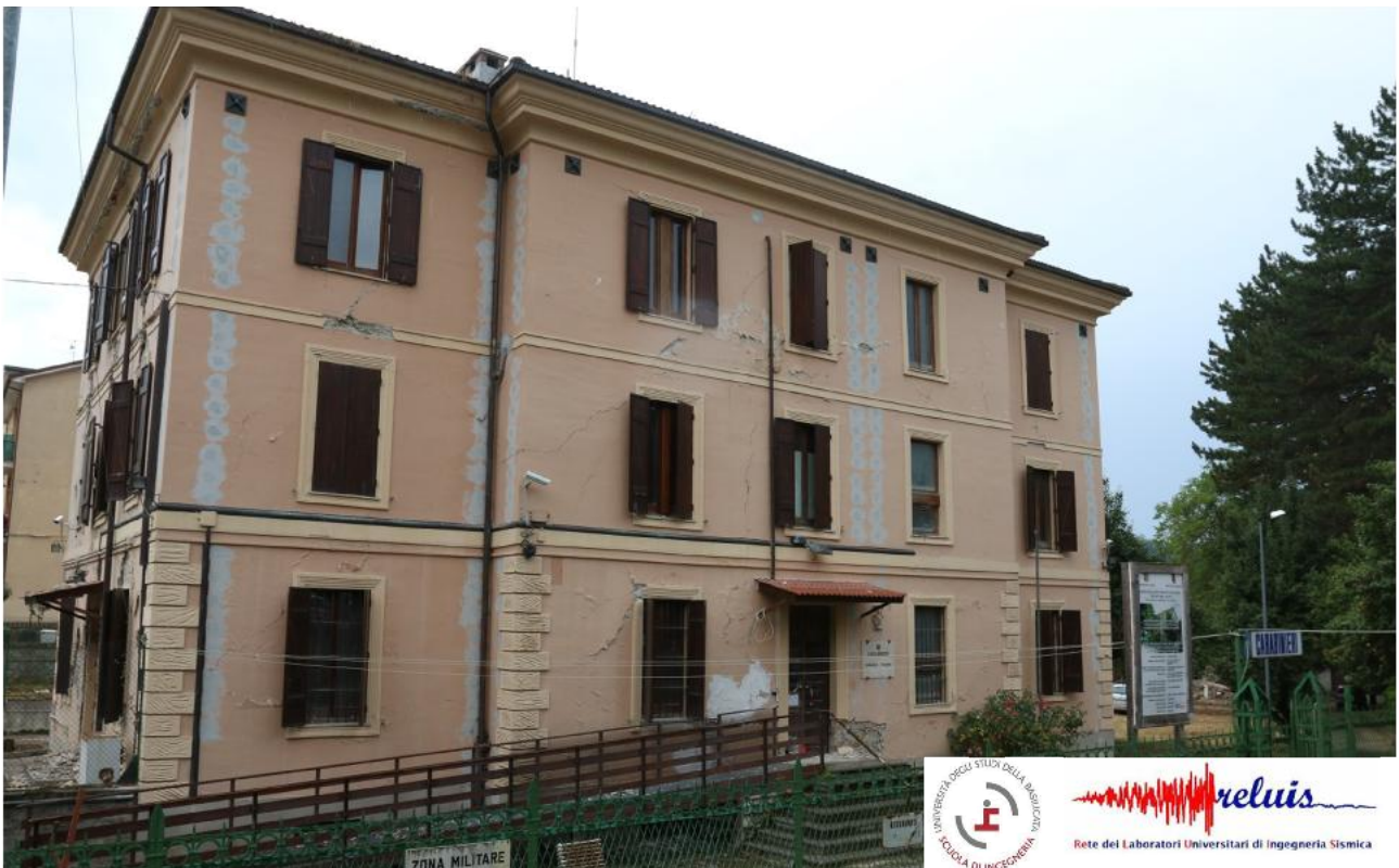
Danneggiamento nel piano di alcuni maschi murari
