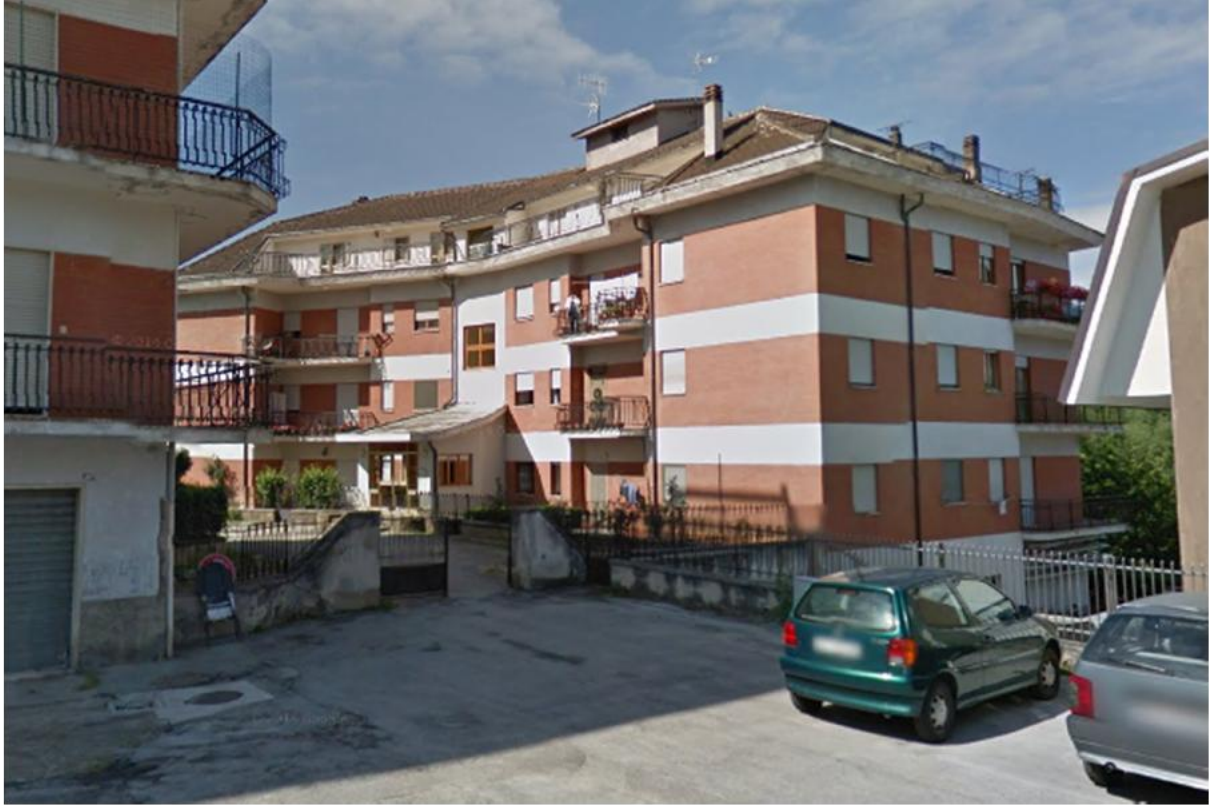
Situazione pre sisma
