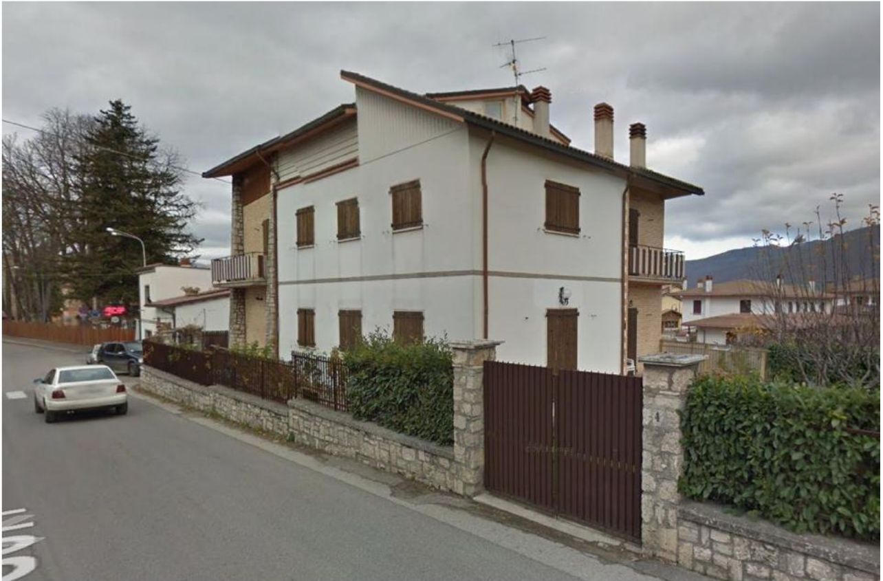
Situazione pre sisma
