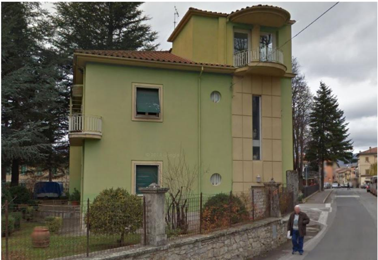
Situazione pre sisma
