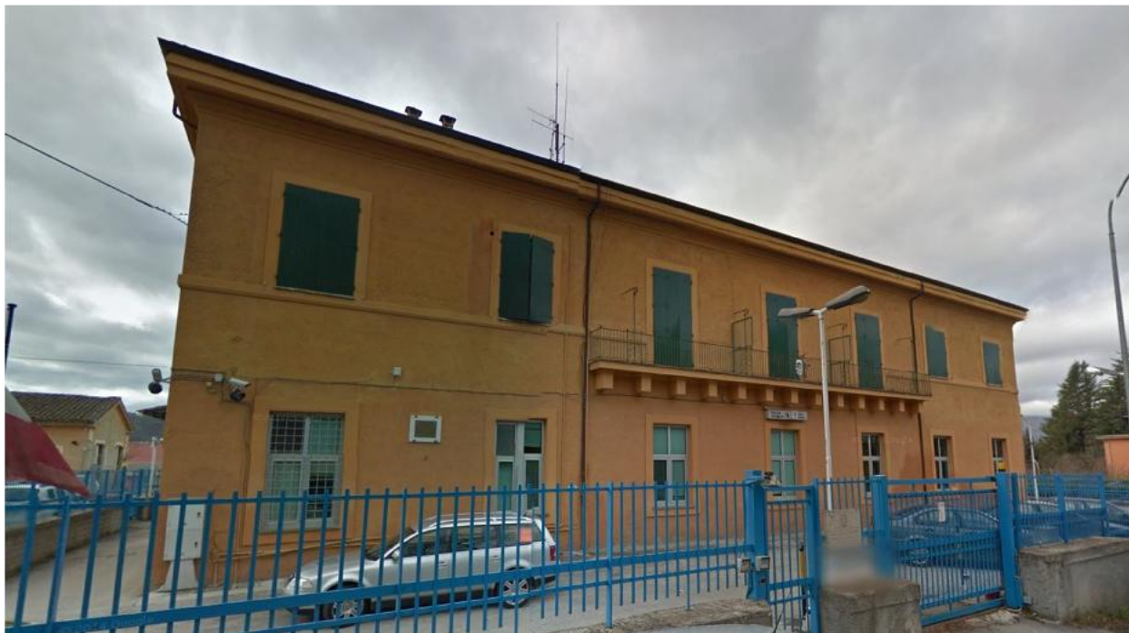
Situazione pre sisma
