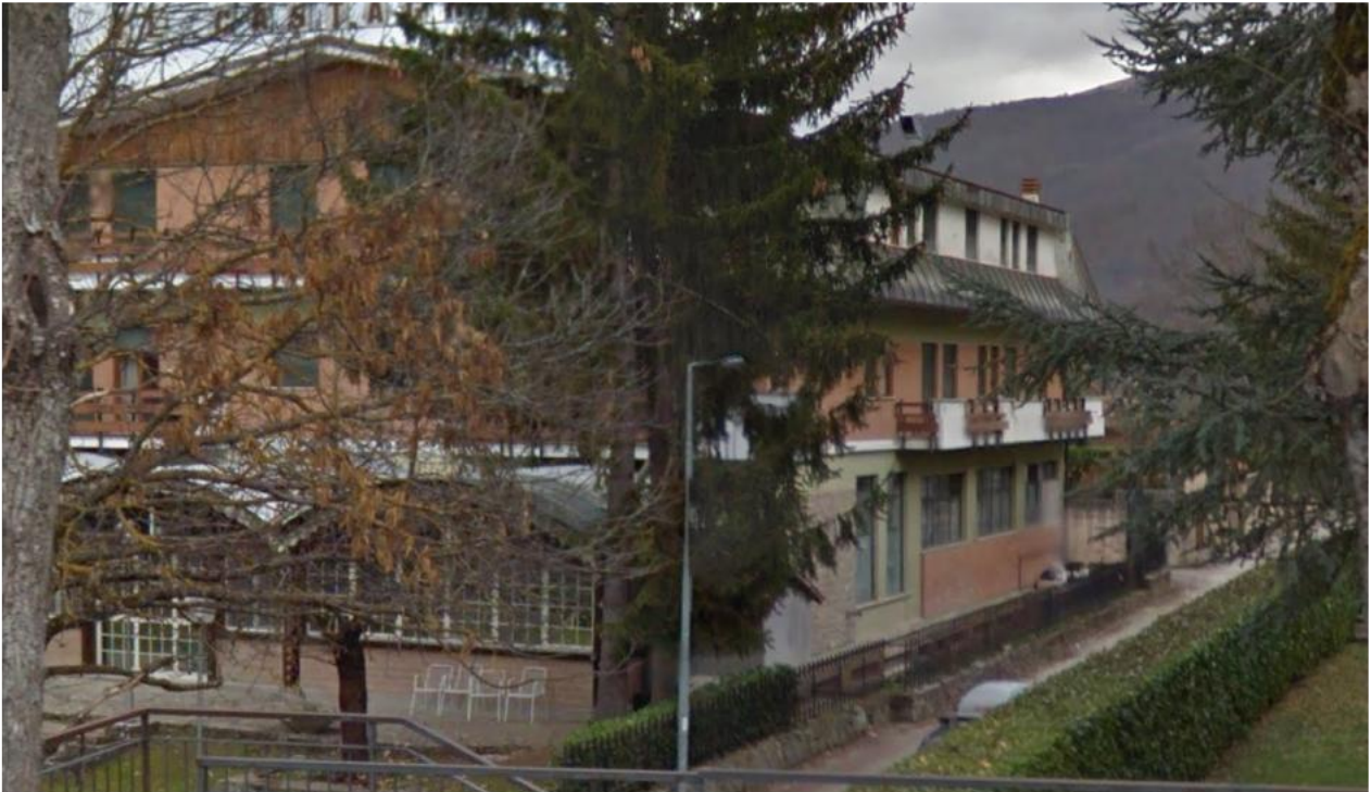
Situazione pre sisma
