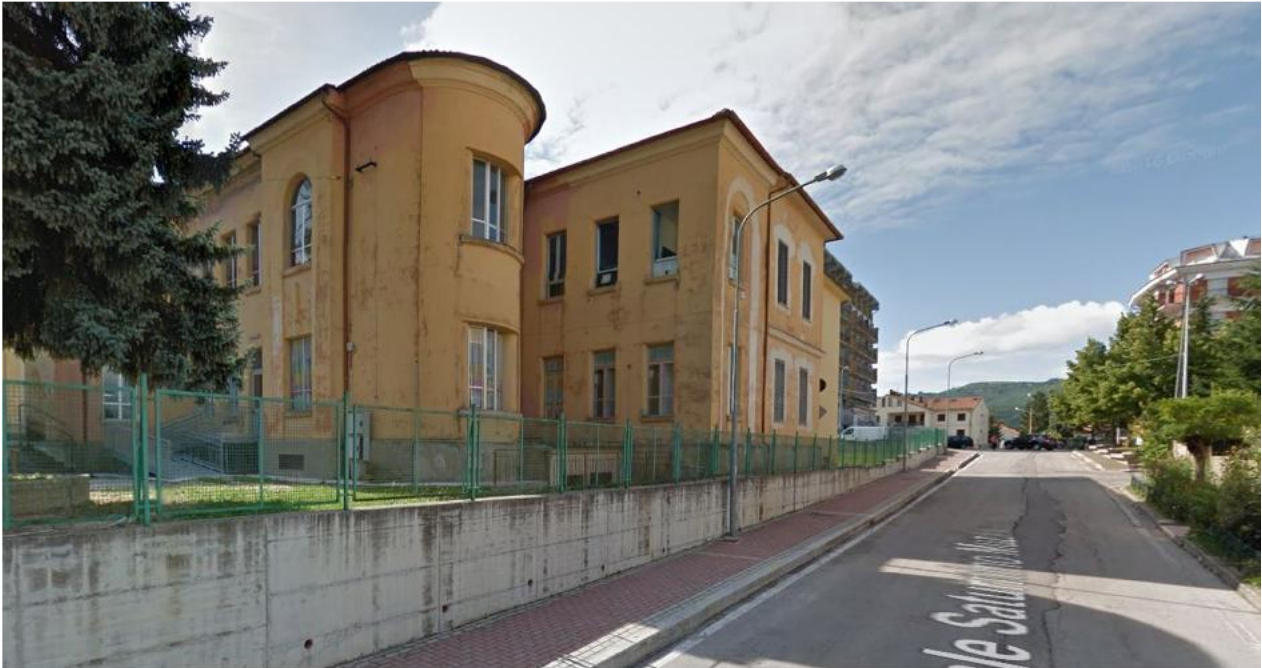
Situazione pre sisma
