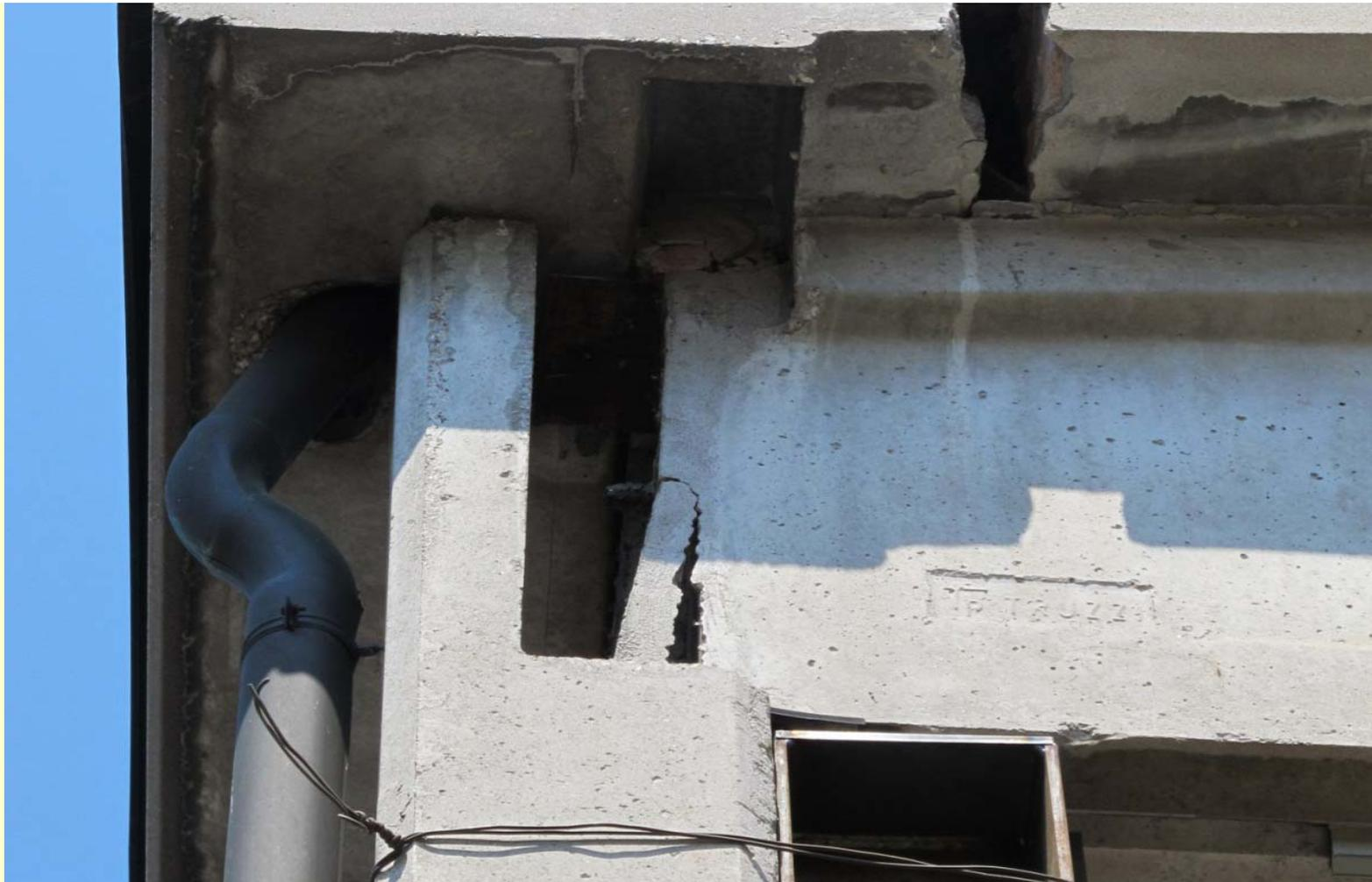
**Intervento di prima urgenza per evitare il collasso di una trave slittata rispetto al pilastro**
