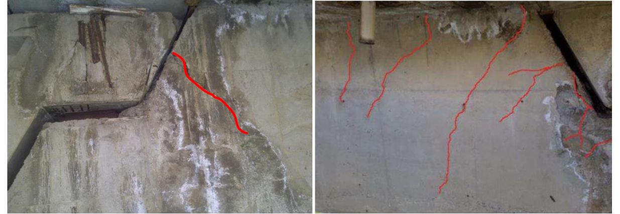
Quadri fessurativi e lesioni dovute a carenze nelle armature di sospensione della mensola gerber inferiore.
