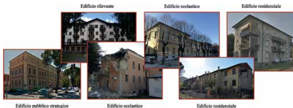
Figura 2.3. Edifici in muratura portante selezionati come casi studio.
