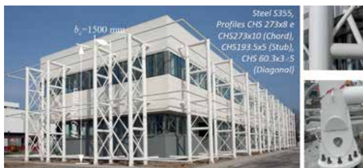
(a) Edifici uffici Magneti Marelli (BO, Italy)
