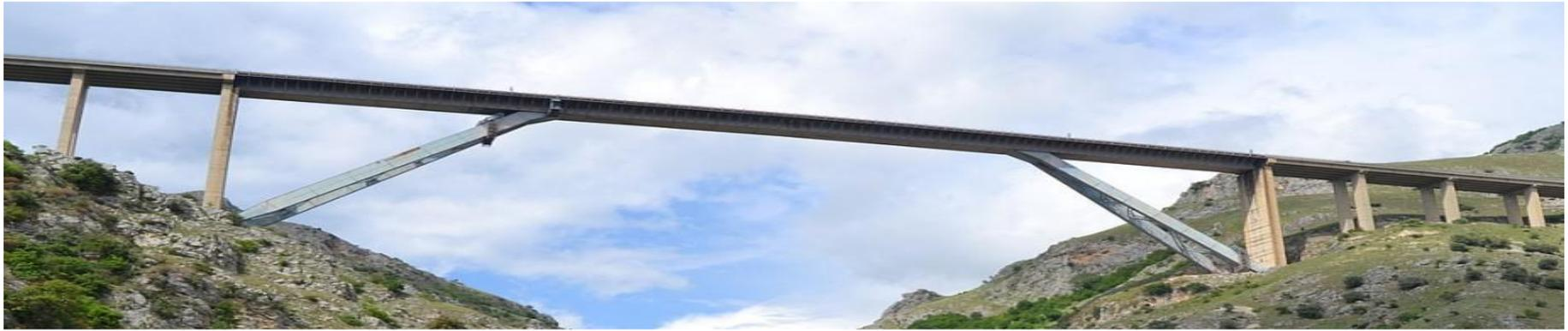
L'opera è costituita da un **arco-telaio d'acciaio** di grande luce, che supera la profonda incisione del torrente Platano, e dai due **viadotti d'accesso iperstatici** realizzati con impalcati a travi prefabbricate in c.a. precompresso.
