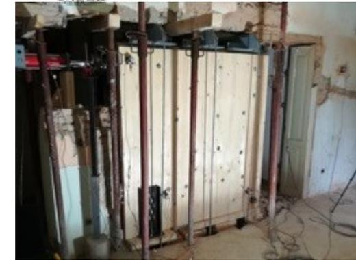
Miglioramento sismico ed efficientamento energetico con pannelli CLT e OSB
