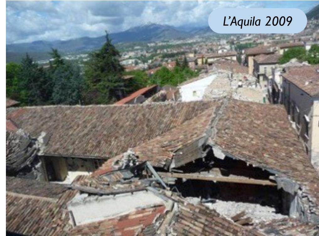
Orizzontamenti deformabili e non collegati alle murature, coperture degradate e «spingenti»
