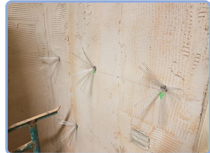
Intonaco armato con rete in GFRP e metodo ibrido con con rete in GFRP e ristilature armate sull'altro lato
