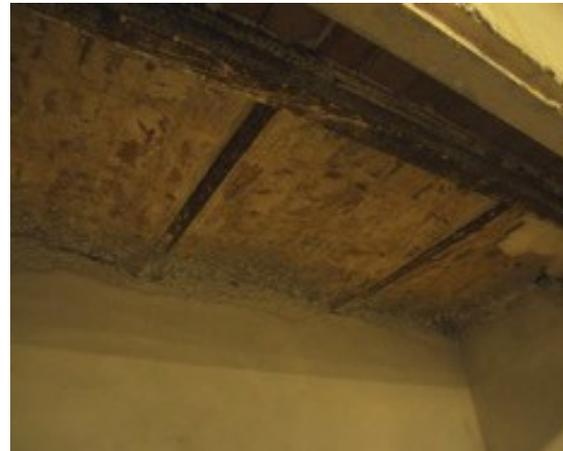
Solaio in laterocemento con cappa non armata (piano 2)
