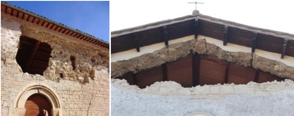
3) Connessione con la muratura sottostante
