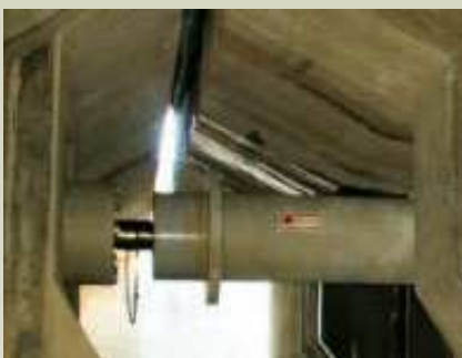
Dissipatore viscoso ricentrante (FIP installazione Rio Higuamo Bridge).
