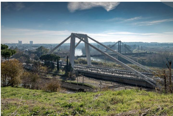
Primo ponte strallato in cemento armato precompresso realizzato a Roma e l'unico, tra i viadotti strallati di Morandi, che sostiene un tratto stradale curvilineo.
