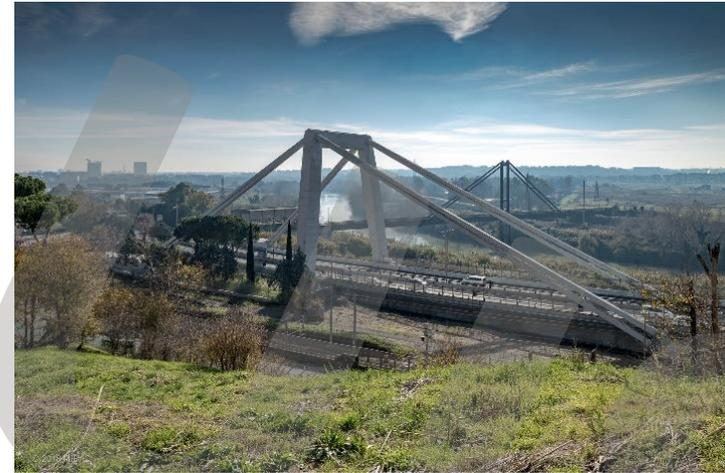
Il viadotto Ansa del Tevere, progettato da Riccardo Morandi nel 1965 per l'autostrada Roma-Fiumicino, è il primo ponte strallato in cemento armato precompresso realizzato a Roma e l'unico, tra i viadotti strallati di Morandi, che sostiene un tratto stradale curvilineo. La soluzione strallata fu adottata in seguito ad una frana che trascinò con sé alcuni piloni dell'autostrada Roma-Fiumicino, allora in costruzione.
