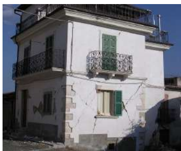
Figura 5-21 – Meccanismi di secondo modo: (a) risposta nel piano delle pareti in un edificio colpito dal sisma dell'Aquila nel 2009, concentrata al piano terra; (b) lesioni a taglio nei maschi del primo piano in una scuola colpita dal sisma del Centro Italia del 2016.
