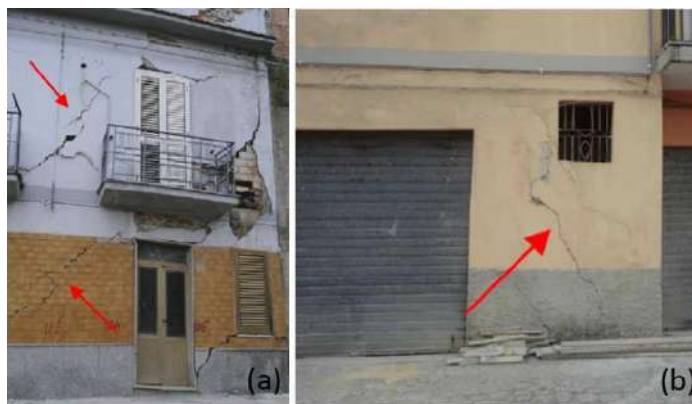
Figura 6-3 – Esempi di danni strutturali causati da frane: (a) San Fratello (provincia di Messina) (Bianchini et al., 2015); (b) Verbicaro (provincia di Cosenza) (Nicodemo et al., 2014).
