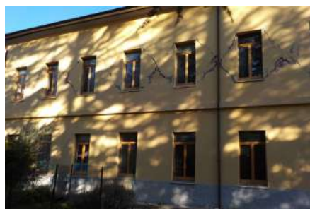
Figura 5-21 – Meccanismi di secondo modo: (a) risposta nel piano delle pareti in un edificio colpito dal sisma dell'Aquila nel 2009, concentrata al piano terra; (b) lesioni a taglio nei maschi del primo piano in una scuola colpita dal sisma del Centro Italia del 2016.
