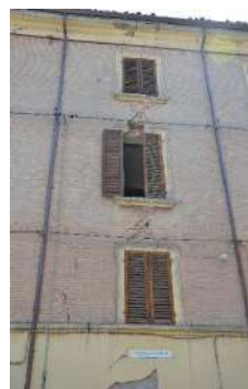
Figura 5-22 – Danno sismico alle pareti murarie, concentrato (a) nei maschi (Božidar Stojadinovic, NISEE/PEER Library, University of California, Berkeley); (b) nelle fasce.
