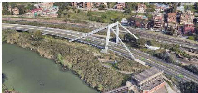
Figura 10-29 – Viadotto Ansa del Tevere (Google Earth).
