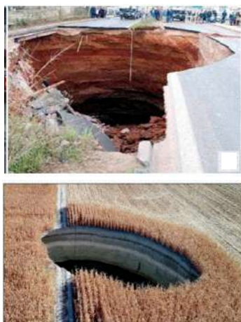
Figura 4-5 – (a) Classificazione dei sinkholes rispetto al meccanismo di collasso del terreno e alla natura del materiale coinvolto (Waltham e Fookes, 2003). (b) Esempi di sinkholes in ambito urbano e rurale (Kontogianni e Stiros, 2020; Orhan et al., 2021). (c) Deformazione del piano campagna e collasso a seguito della costruzione di una galleria in ambito urbano (Kontogianni e Stiros, 2020).
