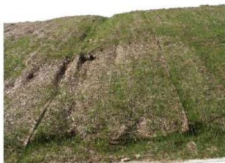
Figura 7-8 – Esempio di danneggiamento dovuto al dilavamento del rilevato di approccio (MIT, 2020).
