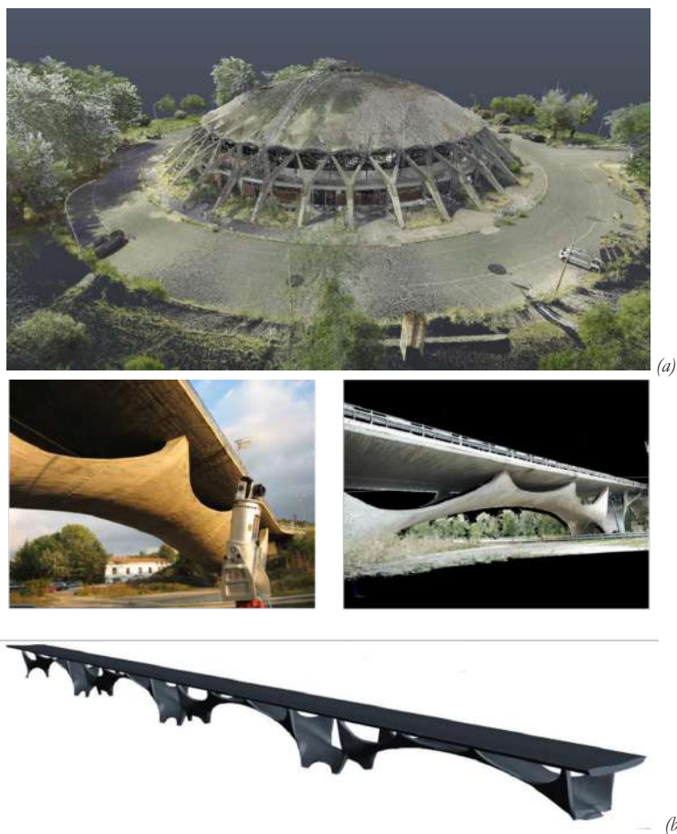
Figura 2-30 – Esempi di restituzione dei risultati ottenuti da rilievo laser scanner: (a) Laser Scanning Palazzetto dello Sport, Roma (React Studio); (b) Viadotto dell'industria sul fiume Basento, (Candela et al., 2020).
