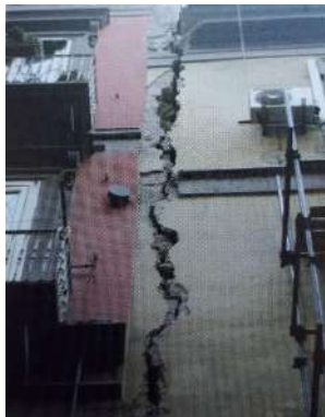
Figura 6-4 – Tipologie di danni strutturali per edifici in c.a. in seguito all'azione delle acque: Napoli – cedimenti subiti da un edificio a seguito di un nubifragio (Augenti, 2009).
