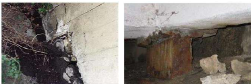
Figura 7-12 – Esempi di difetti sugli appoggi (MIT, 2020).
