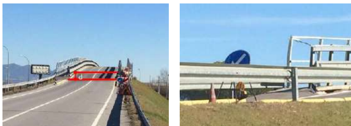
Figura 7-9 – Esempi di danneggiamenti dovuti al dissesto del rilevato di approccio – Deformazioni (MIT, 2020).
