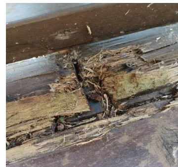
Degrado del tavolato individuato durante le ispezioni di balconi in legno
