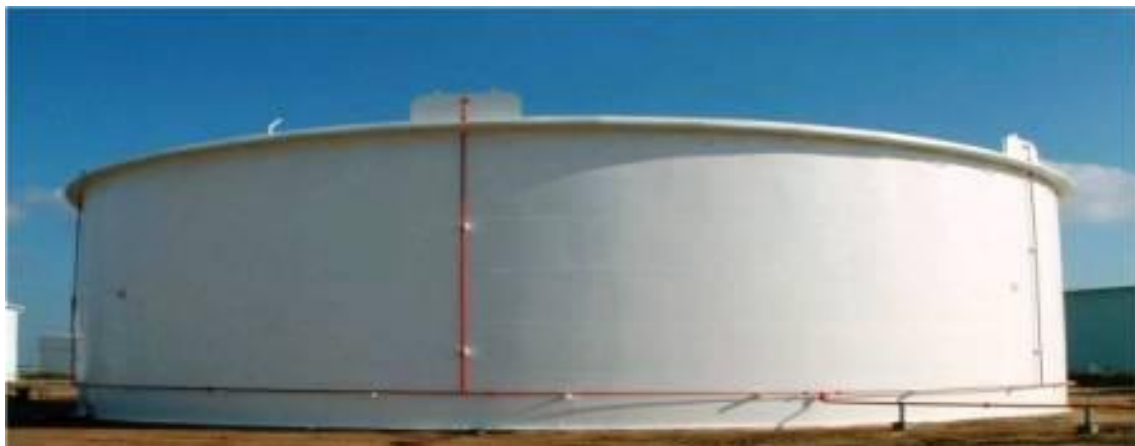
Serbatoio a tetto galeggiante diametro D=86 m e altezza H=22 m
