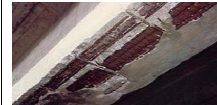
Esempio intensità: distacco copriferro/guaine in vista corrose
