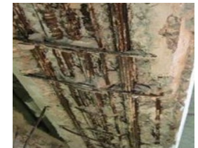
Esempio intensità: fili in vista corrosi/rottura fili
