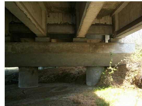
Accumulo materiale in frana a ridosso pila
