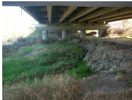
Nicchia di distacco sottostante viadotto
