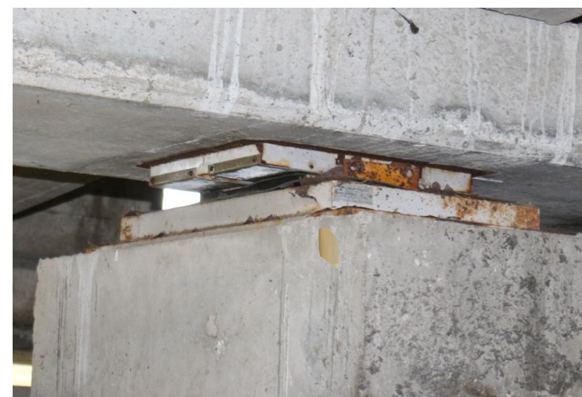
Superfici in acciaio-Teflon
