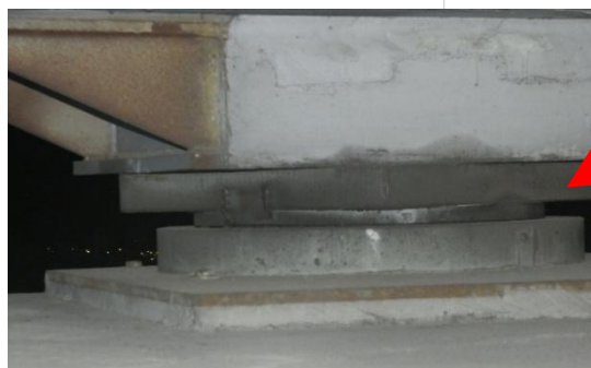
Disco elastomerico confinato (Pot)
