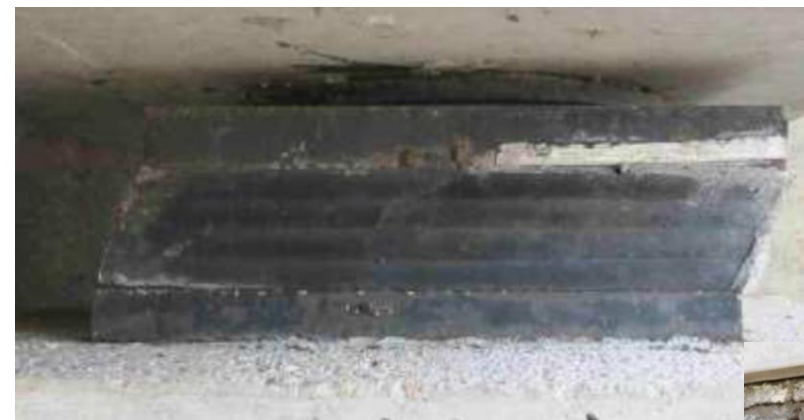
Eccessiva deformazione orizzontale
