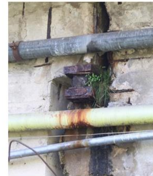
Ossidazione ed esfoliazione di appoggio a rullo
