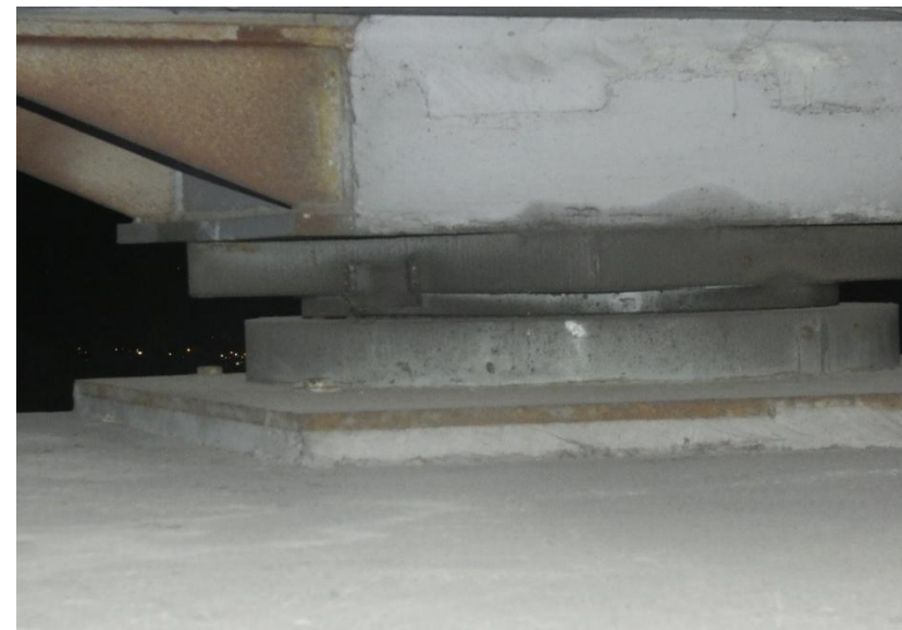
Disco elastomerico confinato
