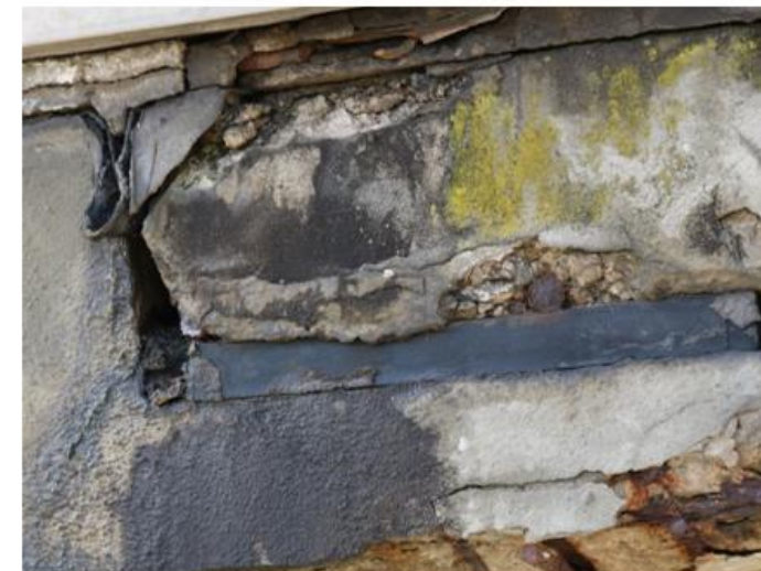
Invecchiamento neoprene in appoggio su sella Gerber
