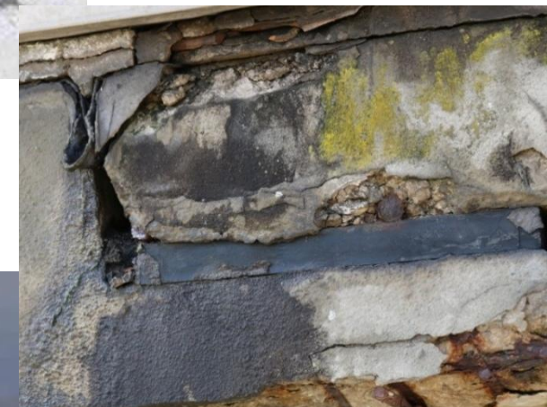
Invecchiamento neoprene (appoggio su sella Gerber)
