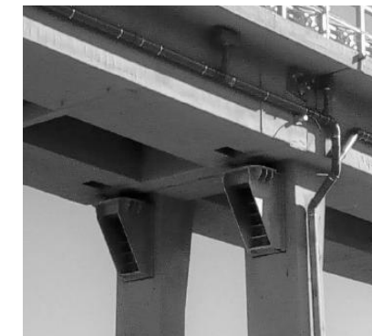
Figura 1-19. Installazione di mensola metallica per defunzionalizzazione di sella Gerber in prossimità di una pila (Morano 2022)
