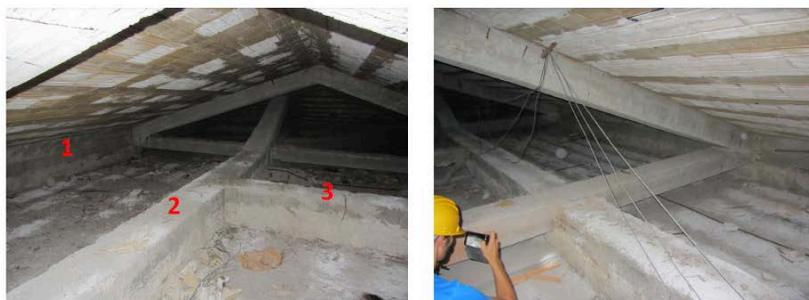
**Figura 8** – Presenza di cordoli rilevati nel sottotetto.
