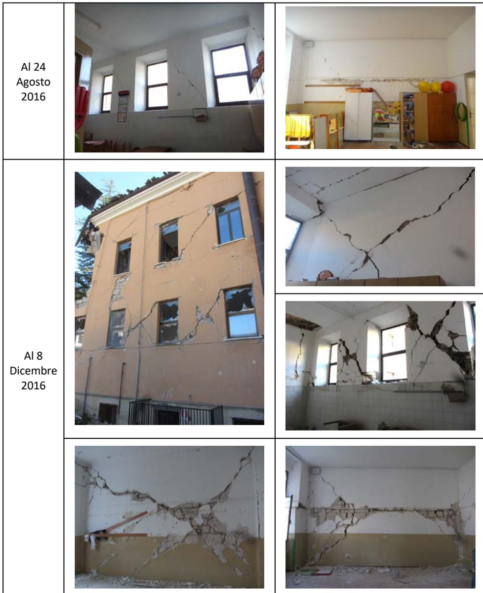
**Figura 4** – Ulteriori immagini relative al danno occorso nella Scuola “P. Capuzi” di Visso (MC) che documentano l’attivazione di una risposta prevalente nel piano delle pareti (sia esterne che interne) (Le foto del 24 agosto 2016 sono state messe a disposizione dall’Osservatorio Sismico delle Strutture del Dipartimento della Protezione Civile, quelle dell’8 Dicembre 2016 sono state scattate da Serena Cattari)
